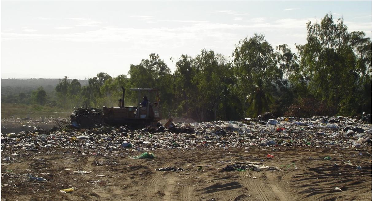
FIGURA 23 – Operação do trator de compactação no topo na trincheira, com vegetação protetora ao fundo no ASML em Aquiraz.
