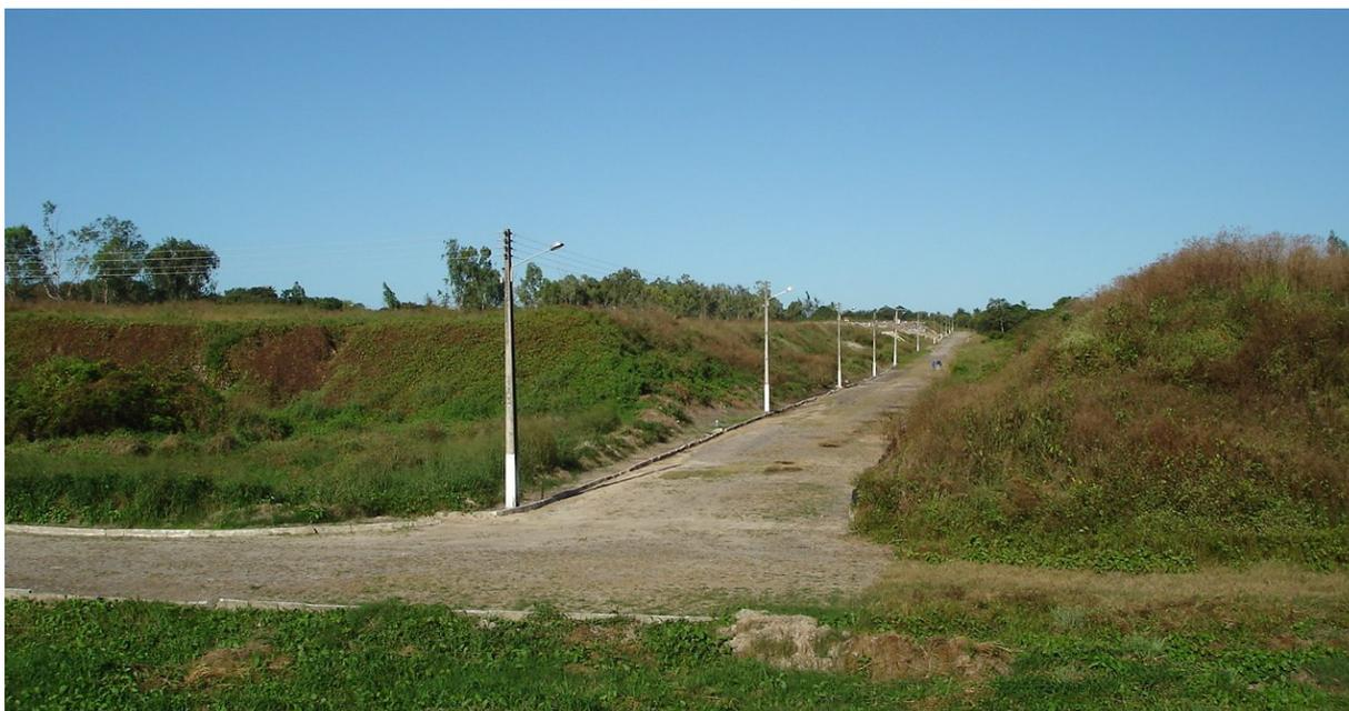
FIGURA 22 – Vista parcial do ASML com trincheiras lacradas, iluminação, calçamento e vegetação protetora em Aquiraz.
