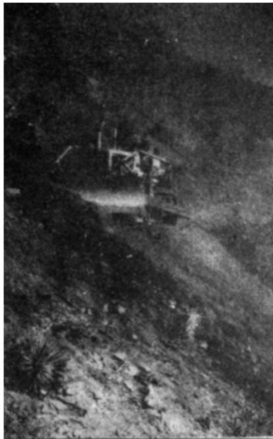
Roadbuilder abrindo, como "vanguardeiro" um caminho em encosta abrupta.
