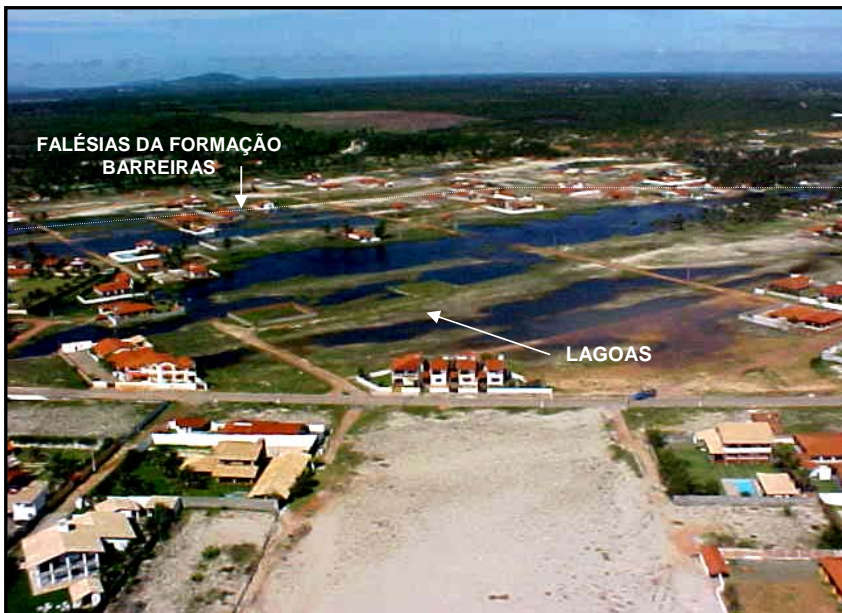
Figura 8. Lagoas freáticas em Águas Belas nos Terraços Marinhos Holocênicos. No período chuvoso as águas invadem as estradas e casas de veraneio criando situações de riscos.
