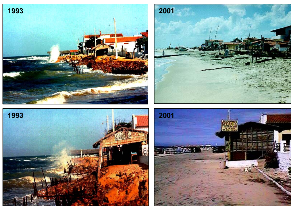
Figura 62. Aspectos evolutivos da praia da Caponga entre os anos de 1993 e 2000. Observar a reconstituição da paisagem através dos gabiões e da alimentação artificial.
