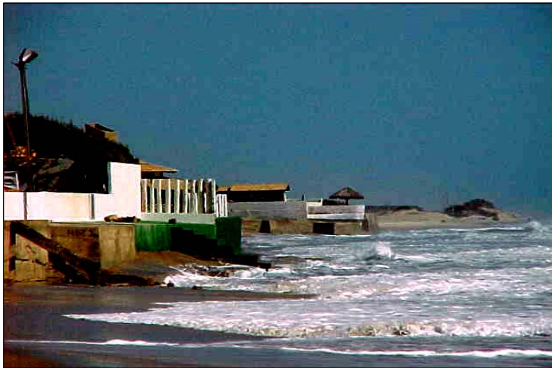
Figura 68. Ataque frontal das ondas na faixa de praia entre a foz do Riacho Caponga Roseira e a praia do Balbino (agosto/01).
