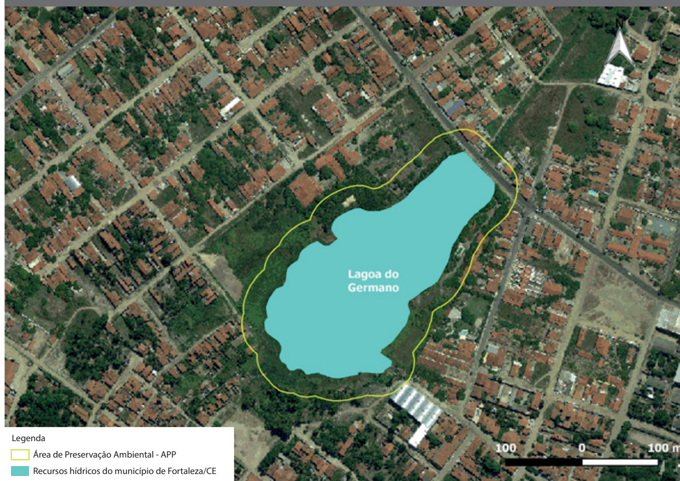
Figura 33 – Imagem da Lagoa do Germano com a delimitação da Área de Preservação Permanente (APP)
