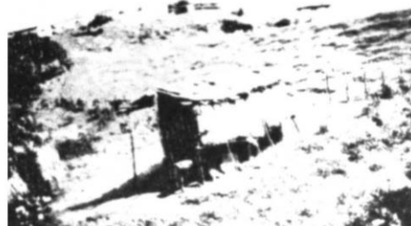
9 — Casebre excessivamente tóxico, de colono. As paredes são de taipa, sendo a de léste, protegida com palhas de carnaúba. A sua cobertura é, uma parte de telhas e o alpendre, de latas de flandre, abertas
