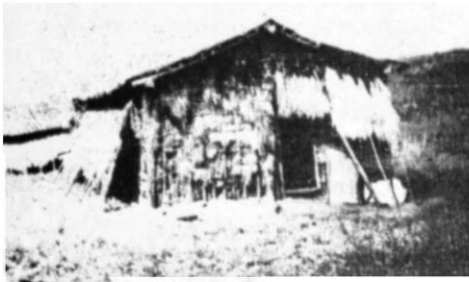
6 — Residência de colono. Casa de taipa coberta de telhas. À proporção que a parede, de barro, vai se estragando, está sendo substituída por palhas de carnaúba. A frente desta está voltada para o norte motivo porque, a «parede auxiliar», de palhas, acha-se ao seu lado direito (léste).
