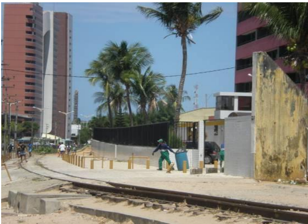
Figura 49. Ocupação da faixa de domínio da ferrovia
