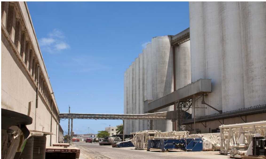
Figura 22. Silos de Armazenagem de Trigo no Porto do Mucuripe
