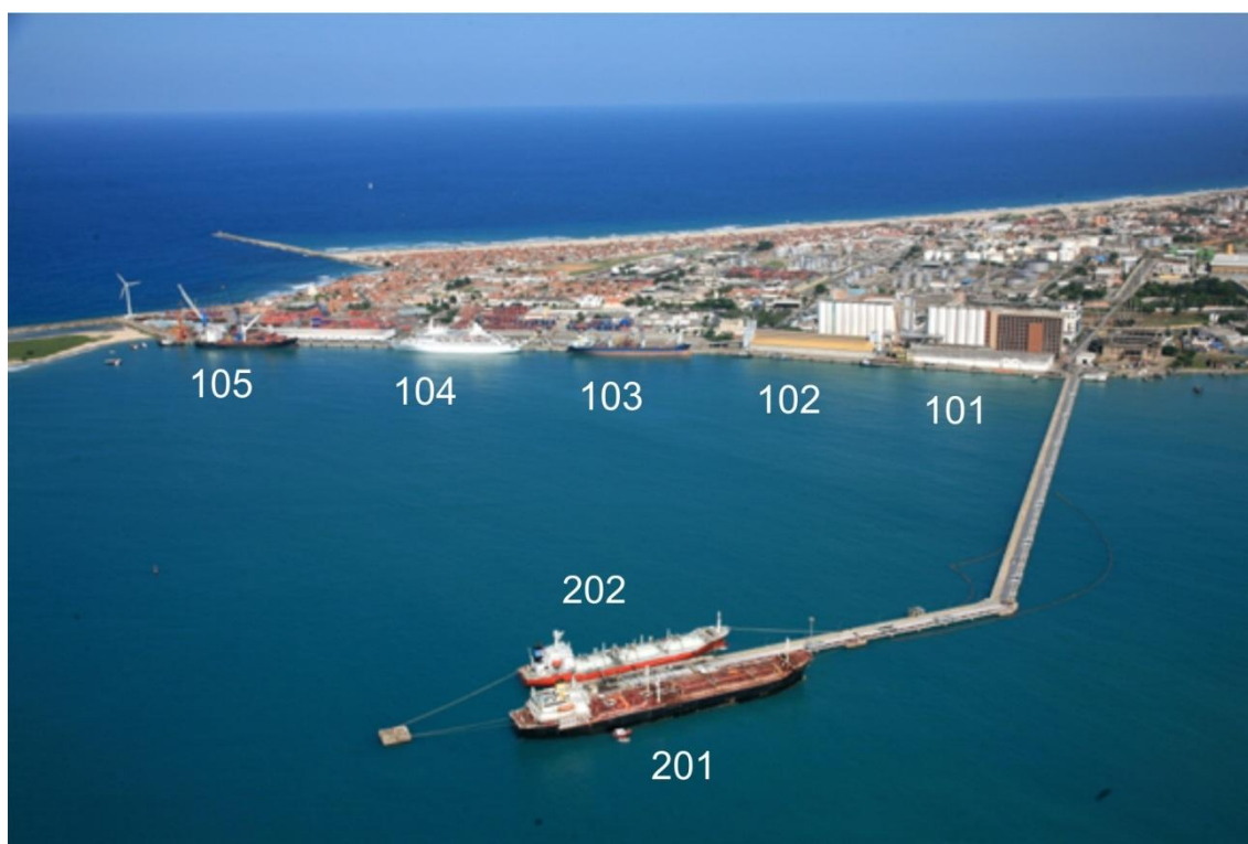
Figura 13. Estruturas de acostagem do Porto do Mucuripe
