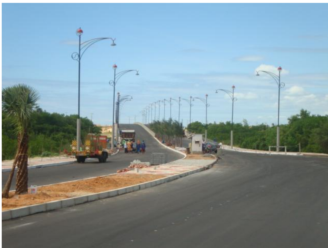
Figura 43. Figura Ponte da Sabiaguaba
