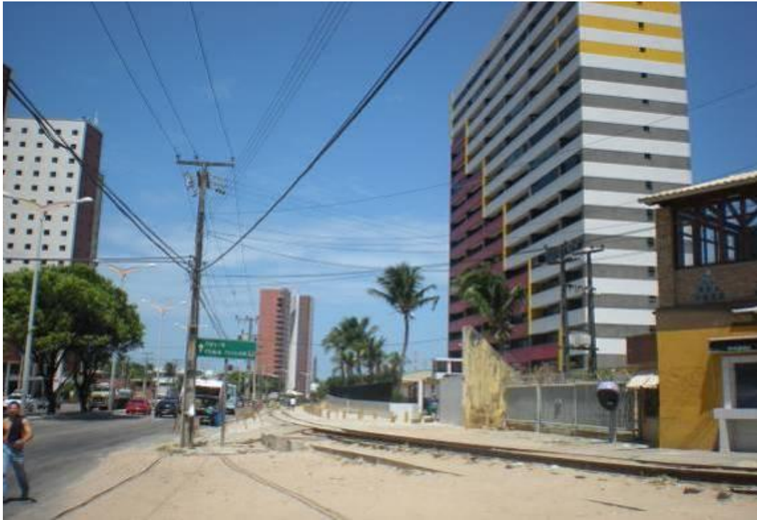
Figura 48. Ocupação da faixa de domínio da ferrovia
