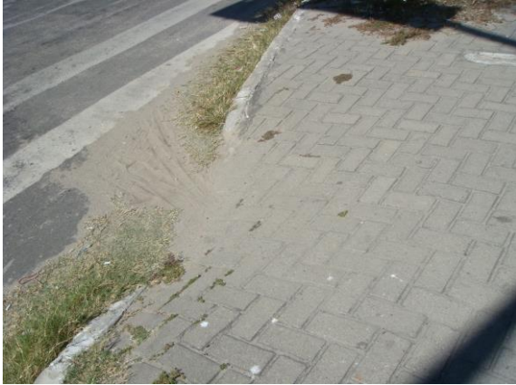
Figura 24 – Situação 07: Acesso a Praça Fonte: registro da autora
