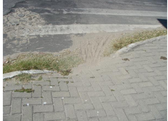
Figura 25 – Situação 07: Acesso a Praça Fonte: registro da autora
