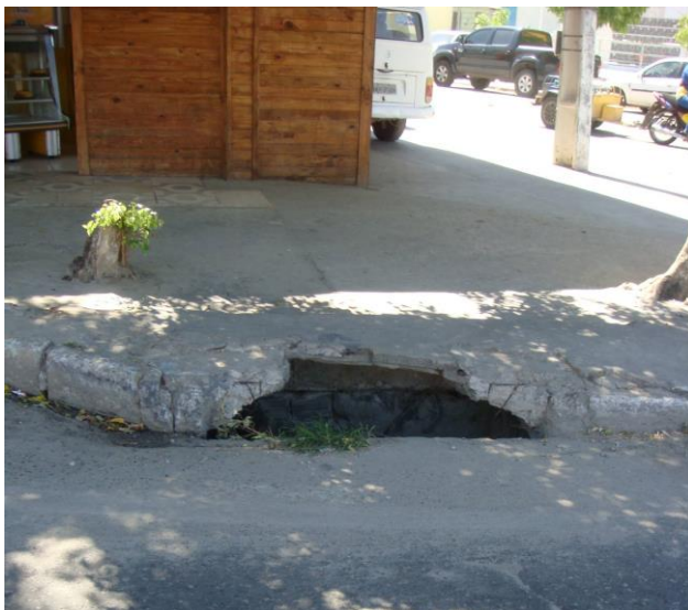
Figura 23 – Situação 06: Boca de lobo Fonte: registro da autora
