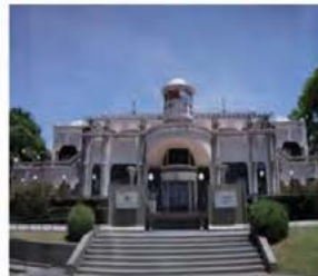
Figura 222 – Centro de Museos de Buenos Aires Fonte: http://www.puertomadero.com/obras_infra.cfm
