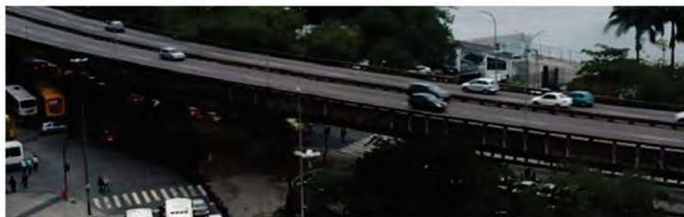
Figura 245 – Elevado da Perimetra (Rio de Janeiro) Fonte: http://oglobo.globo.com/in/2979170-8ad-adt/FT500A/Trecho-do-Elevado-que-ira-abaixo-mas-somente-apos-a-custrucao-de-mergulhaoHudson-PontesO-Globo.jpg
