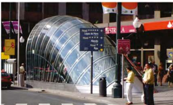
Figura 100 – Estação de Metrô (Design Norman Foster) - (Bilbao) Fonte: http://www.flickr.com/photos/jmhdezhdz/3133666152/sizes/l/in/photostream/
