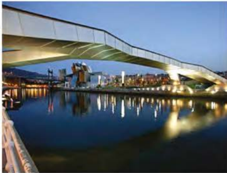
Figura 214 – Remodelação da Ponte Deusto (Bilbao) Fonte: http://www.maurer-soehne.es/files/bauwerkschutzsysteme/images/mass_damper_1_Abandoibarra.jpg
