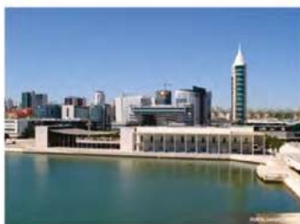
Figura 117 – Pavilhão de Portugal
