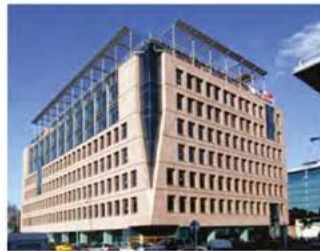
Figura 129 – Sede Mapfre - Dique 2 (Buenos Aires) Fonte: http://www.puertomadero.com/obras_dique2.cfm
