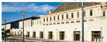
Figura 112 - Estação de transporte intermodal em Belle de Mai (Marselha) Fonte: http://www.euromediterranee.fr/uploads/pics/header-operations-poletransport.jpg
