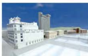
Figura 294 – Restauro Moinho Fluminense. Operação Urbana Porto Maravilha (Rio de Janeiro)
