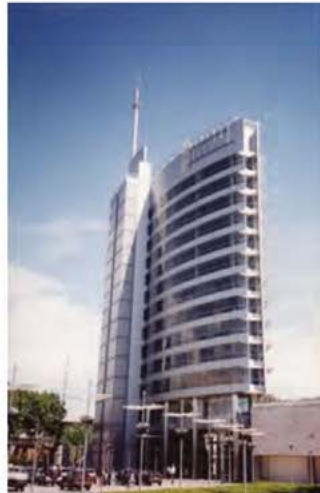
Figura 132 – Edificio Malecón - Dique 2 (Buenos Aires) Fonte: http://www.puertomadero.com/obras_dique2.cfm
