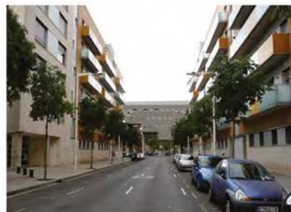
Figura 90 – Edificações residenciais - Vila Olímpica (Barcelona)
