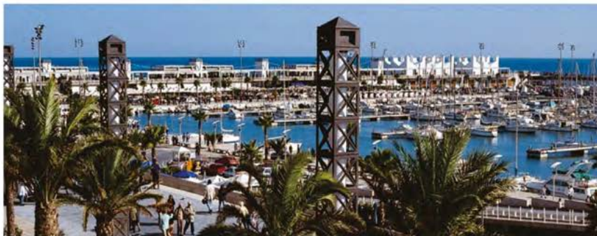
Figura 83 – Vista da área transformada em Barceloneta (Port Vell)
