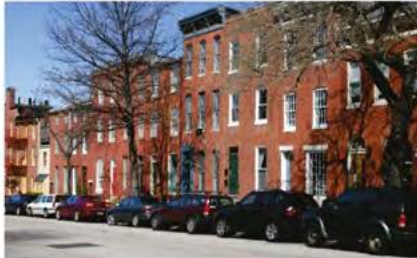
Figura 55 – Área residencial – Rowhouse na Warren Avenue (Baltimore)
