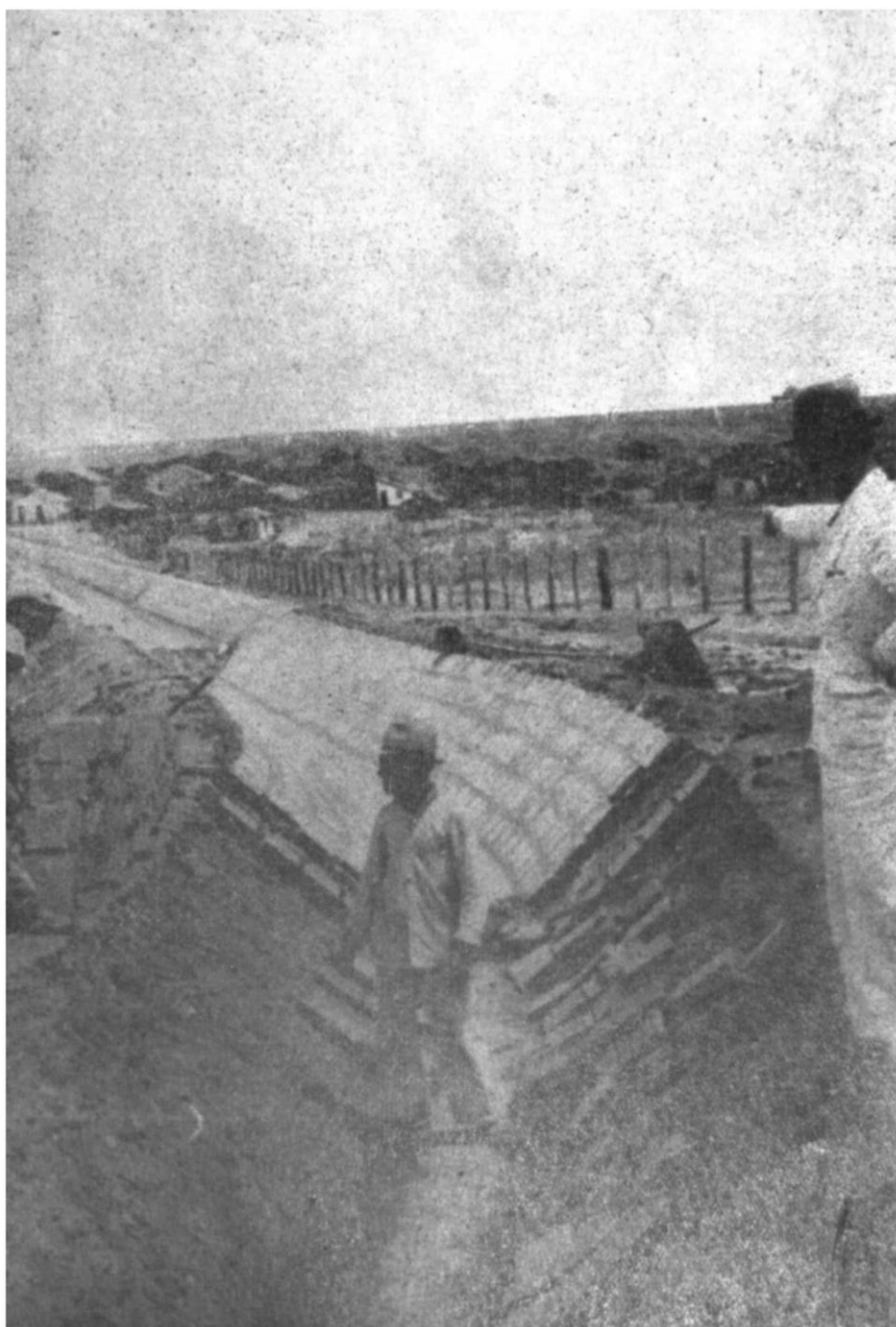
Revestimento a tijolos em canal, no Açude «Condado» — Estado da Paraíba
