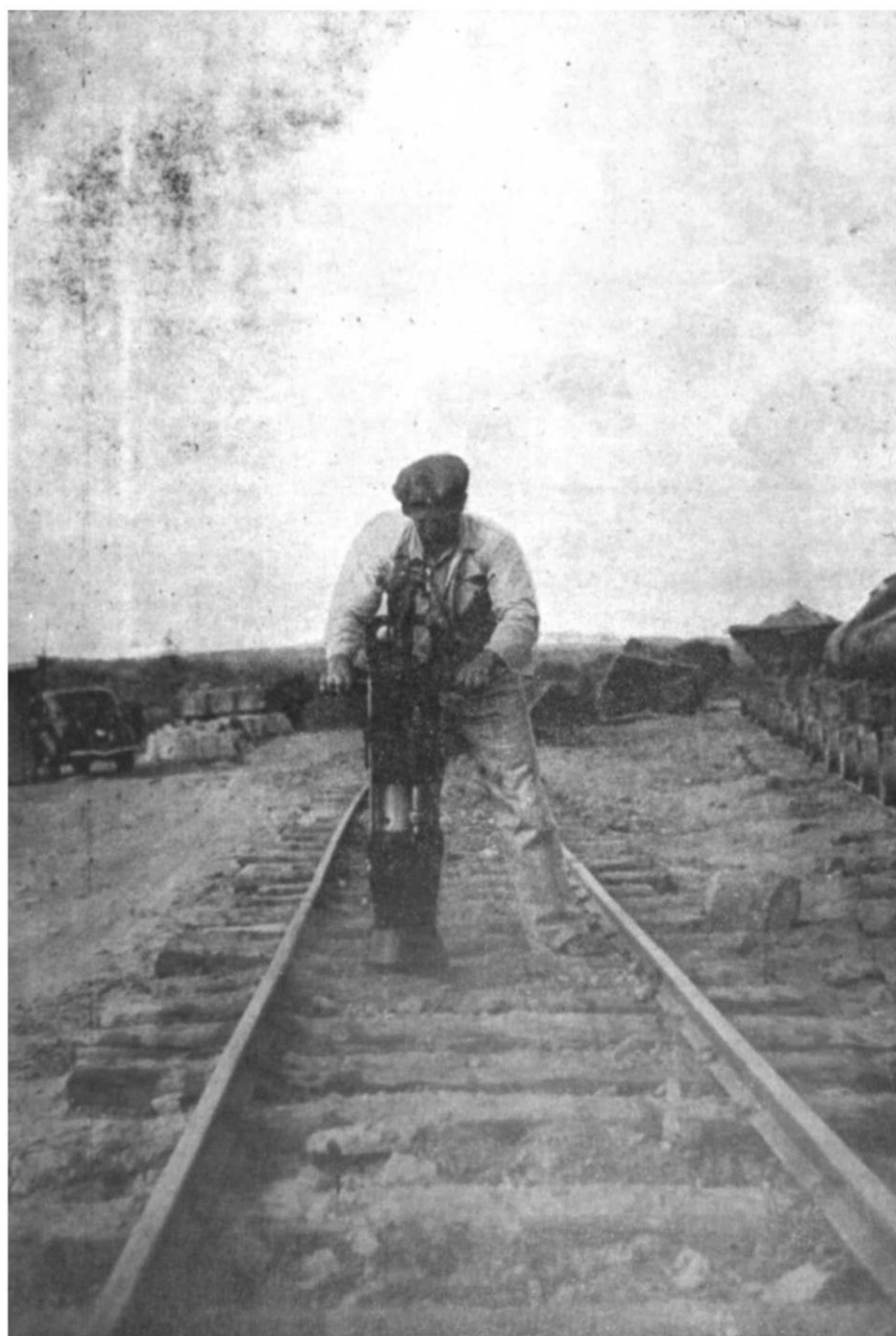
Martelete «Pegson» socando lastro, no Açude «Curema» — Estado da Paraíba
