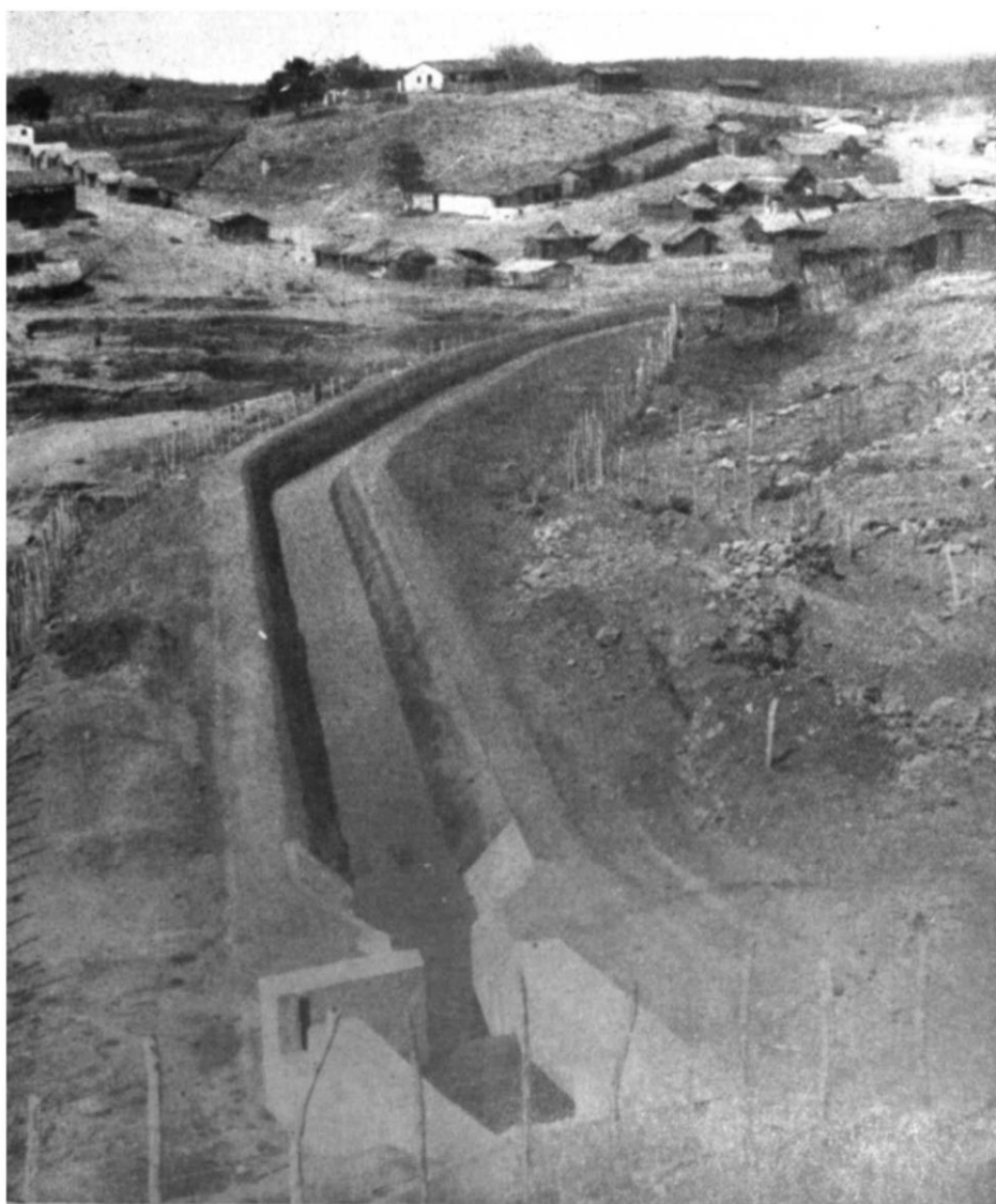
Açude «Forquilha» — Medidor e trecho de canal — Estado do Ceará
