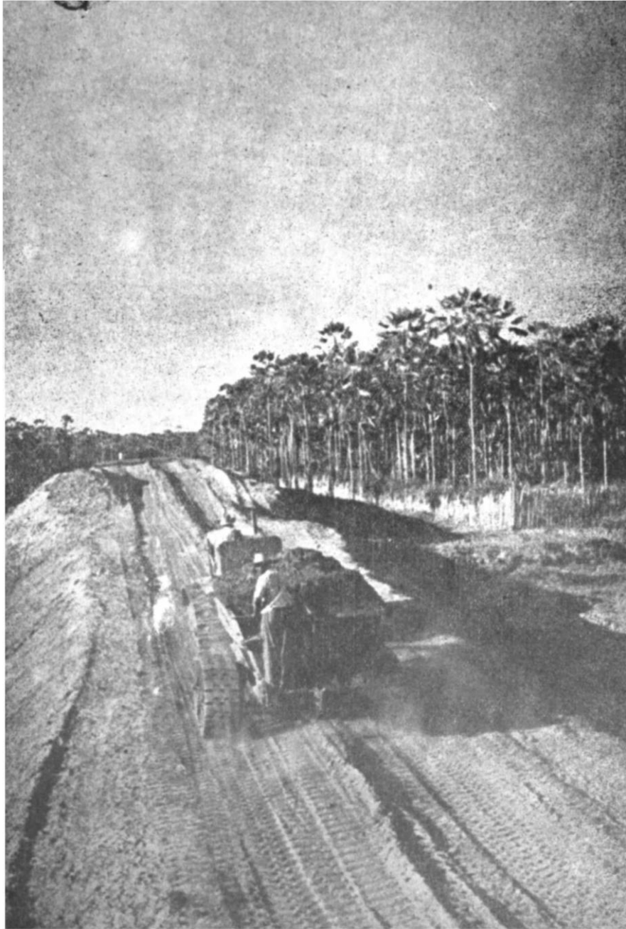
Estrada Transnordestina — Aterro nas várzeas do rio Banabuiú Estado do Ceará
