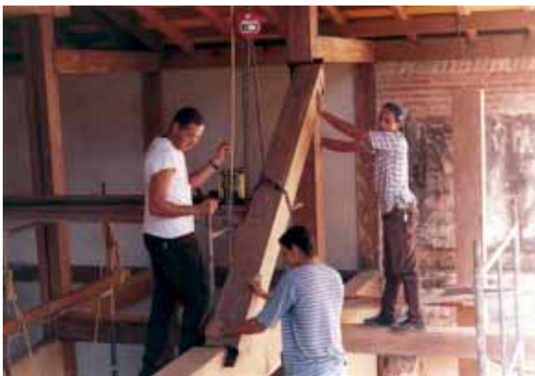
Montagem e Madeiramento - Pirinópolis-GO
