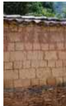
Muro de adobe, Goiás - GO
