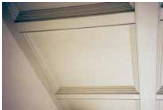
Forro Caixote, Salvador - BA
