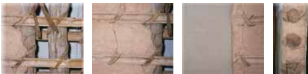
Fases de execução do pau-a-pique, Museu Casa de Cora Coralina, Goiás - GO
