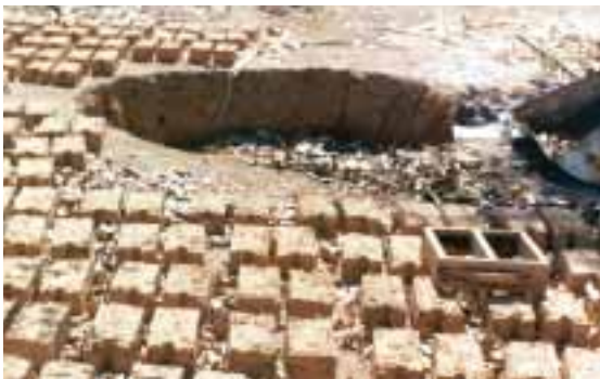
Fabricação de tijolos de adobe
