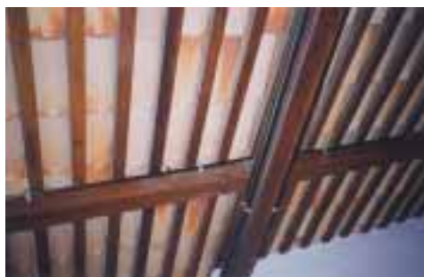
Telhado de caibro chanfrado
