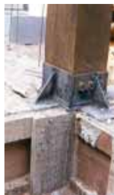
Recomposição com uso de concreto e sapata metálica
