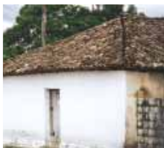
Espigão de telha dupla Cavalcante – GO.
