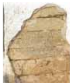
Alvenaria pedra-sabão, Igr. Sta. Bárbara, GO
