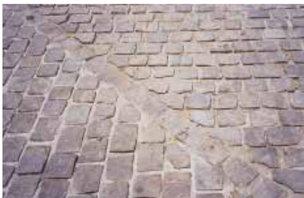
Assentamento de paralelepípedos
