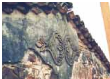
Fachada de argamassa com ornamento
