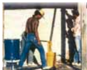
Recipiente de argamassa e, à direita, bomba-sapo
