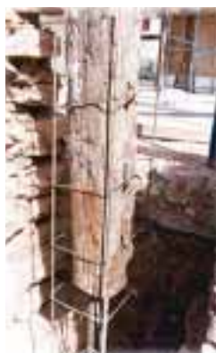
Recomposição com uso de concreto armado
