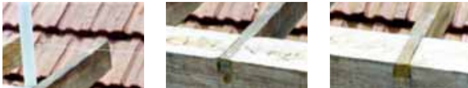
Cachorro com sambladura em malhete
