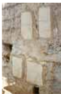
Teste de argamassa
