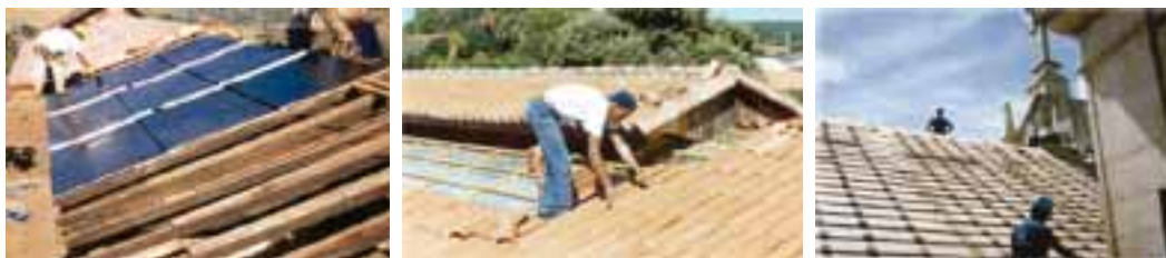
Execução de sobreteto - Pirinópolis - GO
