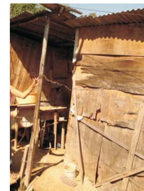
FOTO 11 - Condições precárias de habitação.
