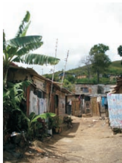
FOTO 02 - Habitações do loteamento
