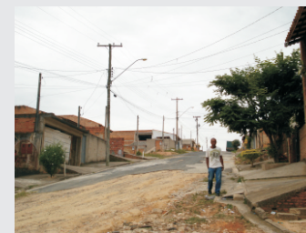
FOTO 04 - trecho onde a obra de pavimentação parou
