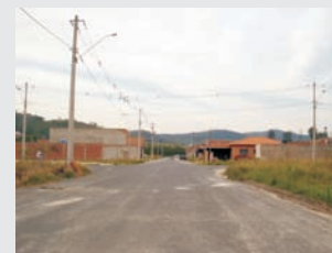
FOTO 05 - Obra de pavimentação já concluída
