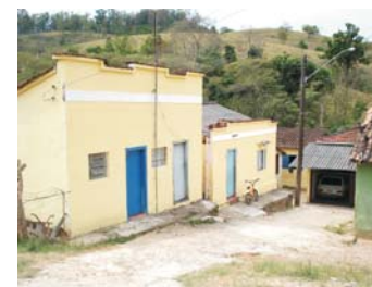
FOTO 06 - gabarito das edificações
