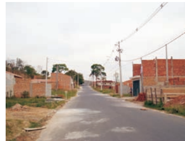
FOTO 03 - Infra-estrutura existente no loteamento
