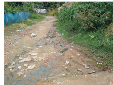
FOTO 04 - Esgoto a céu aberto
