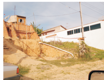
FOTO 10 - Residência em construção: garagem no térreo e cômodos em cima.
