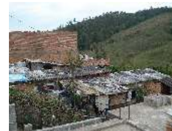
FOTO 15 - Cabitações. Residências abaixo do nível da rua devido a alta declividade do terreno.
