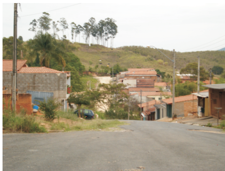
FOTO 02 - Vista do loteamento: trecho das obras de pavimentação acabadas, ao fundo, ruas de terra.
