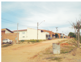
FOTO 02 - Vista do loteamento
