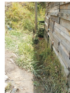
FOTO 21 - Habitações estão construídas em lugares de risco
