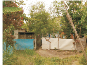
FOTO 15 - Atual condição das residências
