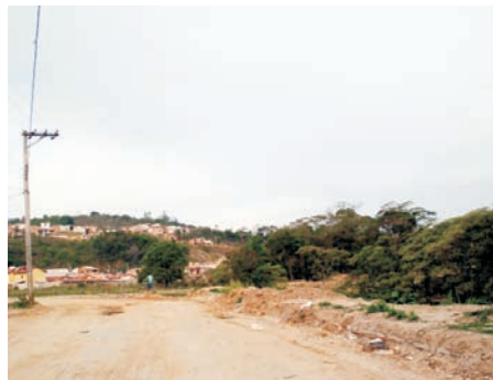
FOTO 03 - Trecho sem pavimentação - APP
