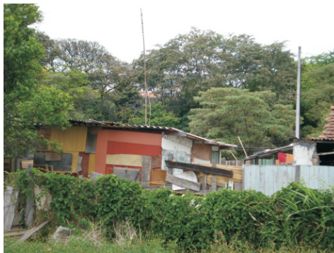
FOTO 05 - Barraco existente aos fundos de uma das residências, próximo ao rio.
