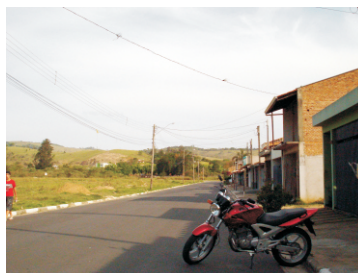
FOTO 03 - Infra-estrutura do loteamento
