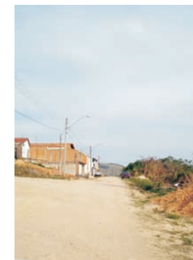
FOTO 11 - Ausência de infraestrutura
