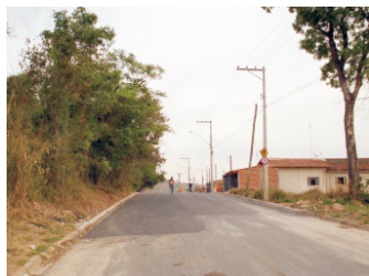
FOTO 01 - Vista do loteamento
