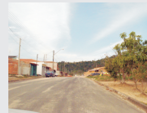
FOTO 05 - Parte onde a obra já está concluída
