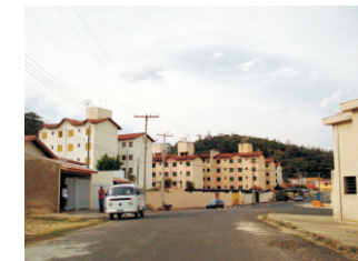
FOTOS 07, 08 e 09 - Gabarito das construções
