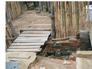
FOTO 05 - Solução encontrada para o escoamento de águas pluviais
