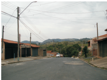
FOTO 01 - Vista do loteamento
