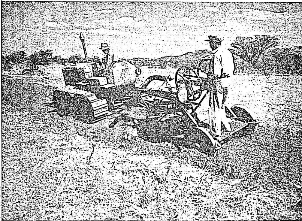
Fig. 2 — Abertura de terraços ou sulcos, em curva de nível para deter a erosão
