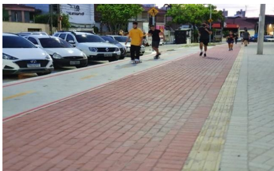
Figura 8 - Pavimentação nova área cooper
