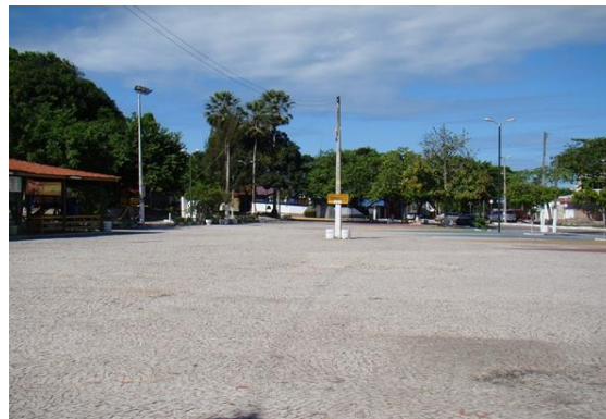
Figura 7 - Pavimentação antiga da praça
