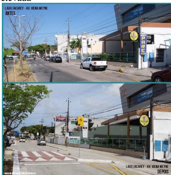
Figura 14 - Av. Viena Weyne travessia elevada
