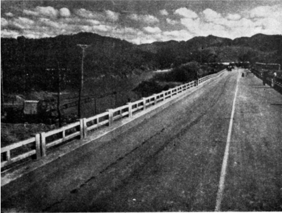
*Foto 1 — Vista da ponte por ocasião do acidente. Observa-se o recalque visível no guarda-corpo (2º plano, à esquerda).*
