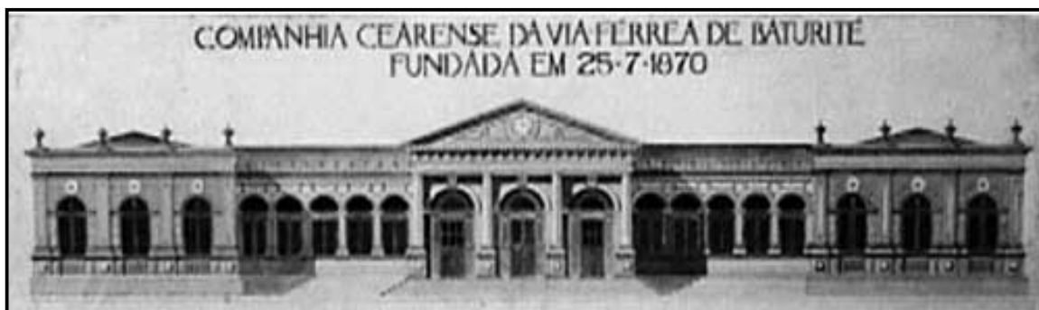
FIGURA 9: Foto que representa a frente da Estação Central. Na Estação Ferroviária João Felipe, no prédio reservado a administração atualmente encontra-se um quadro com esta imagem. Fonte: site: http://www.ofipro.com.br/preservando/estacao.htm .
