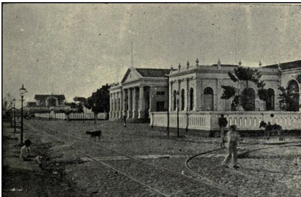
FIGURA – 17: Vista em diagonal direita do Prédio da Estação.
