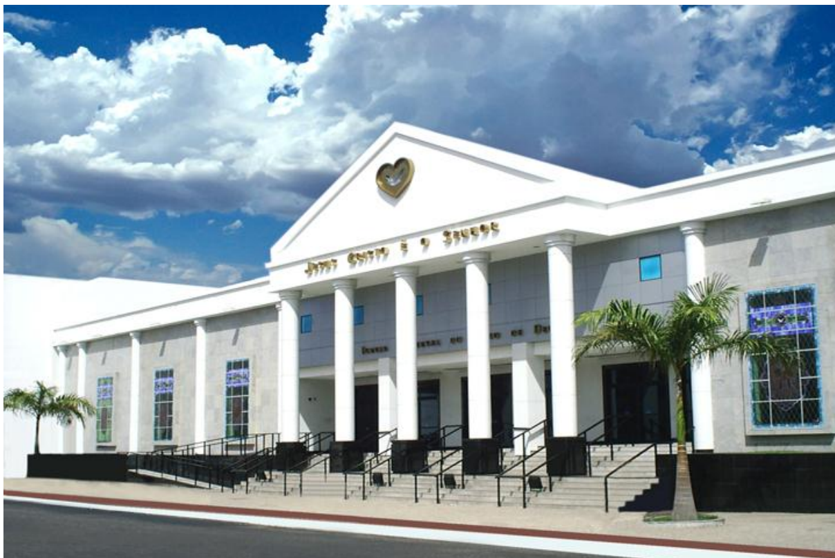
Figura 3. Templo Maior da IURD em Fortaleza-CE – Brasil – Situado na Avenida Tristão Gonçalves, 613, Centro
