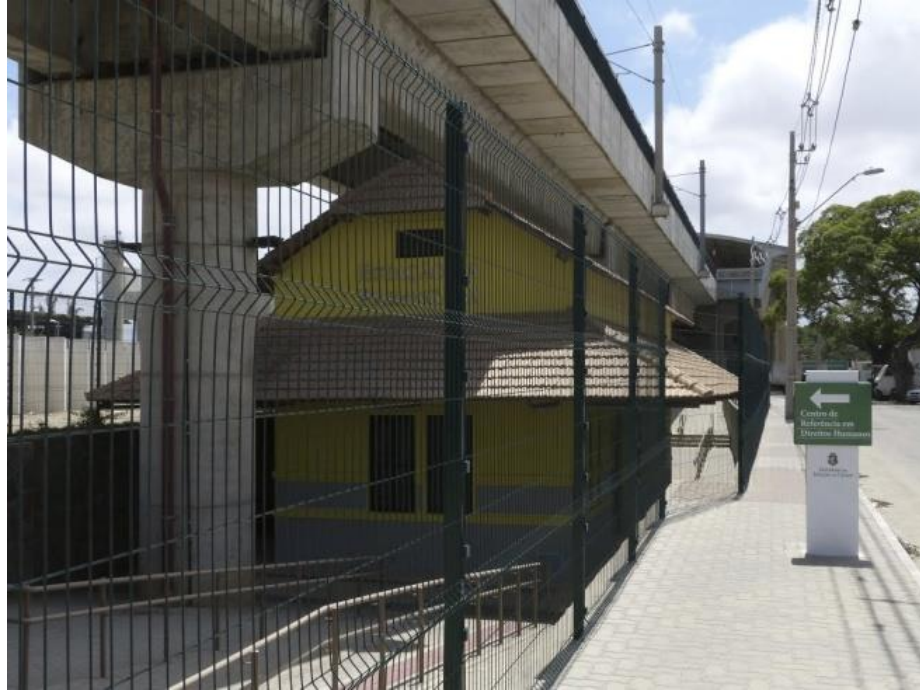
Figura 44 – Antiga estação de Arronches na Parangaba "engolida" pela cidade contemporânea. A estação de metrô se localiza acima da antiga estação
