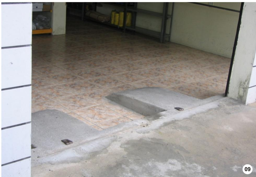
**FOTO Nº 09** - SOLUÇÃO IMPROVISADA PARA APOIAR O ACESSO DO AUTOMÓVEL E CONTER A INVAÇÃO DE ÁGUAS PLUVIAIS (DECLIVE DA CALÇADA NO SENTIDO DO MEIO FIO)
