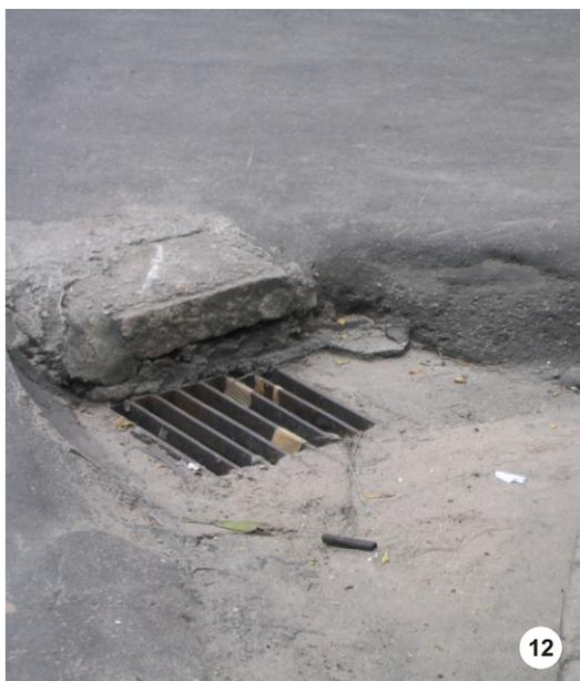
FOTOS Nº 11 e 12 - COM A ELEVAÇÃO DO GREIDE DA VIA POR SUCESSIVOS RECAPEAMENTOS, OCORRE A INVASÃO DAS ÁGUAS PLUVIAIS, CUJA CONTENÇÃO É FEITA, POR MEIOS IMPROVISADOS, PELOS PRÓPRIOS COMERCIANTES
