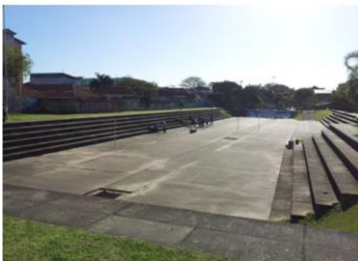
Figura 84 - Exemplo de reservatório de detenção
