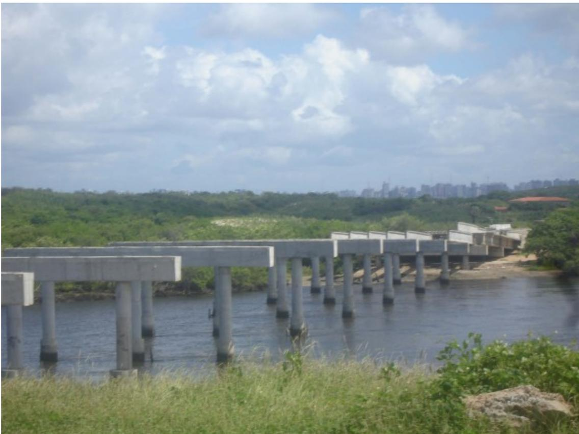
**Figura 61** Construção da ponte sobre a foz do rio Cocó. Além da retirada da vegetação de mangue e terraplanagem de dunas, as pilastras favorecem o assoreamento do rio e acúmulo de bancos de areia.
