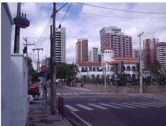
Vista do imóvel a partir do passeio do edifício residencial de interesse na Avenida Rui Barbosa, com destaque para a poluição visual causada por postes e fiação elétrica.
