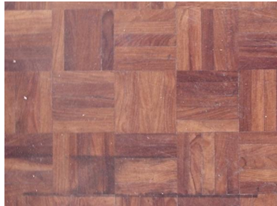
Detalhe da pavimentação em tacos de madeira do salão principal, na ala oeste.
