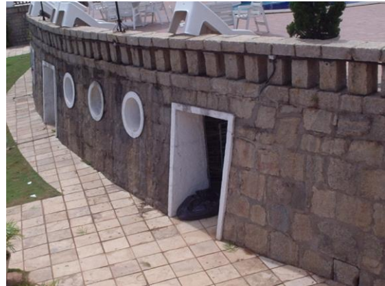
Vista do subsolo com revestimento externo em pedra, a partir do terraço da ala oeste.
