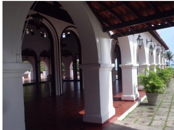
Vista dos pórticos de arcadas da ala oeste, a partir do pórtico de ligação com a ala sul.
