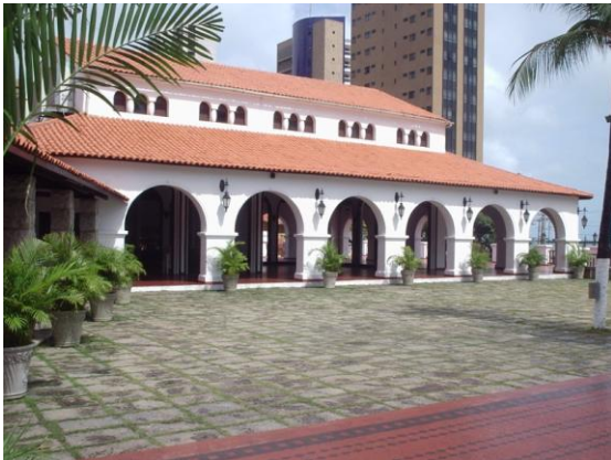
Vista da ala oeste, a partir do terraço, na ala sul.
