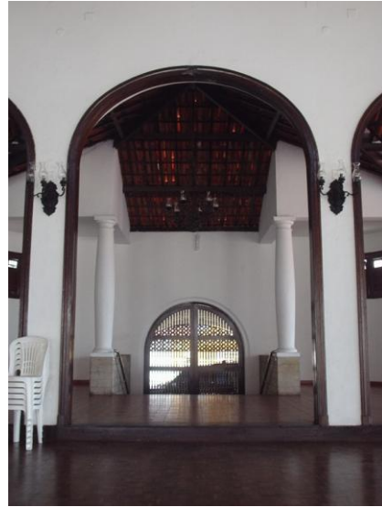
Vista do acesso da ala oeste, a partir do salão principal.
