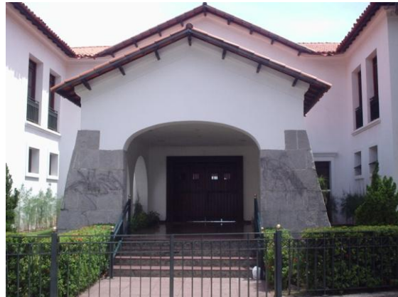
Vista do acesso principal do edifício.
