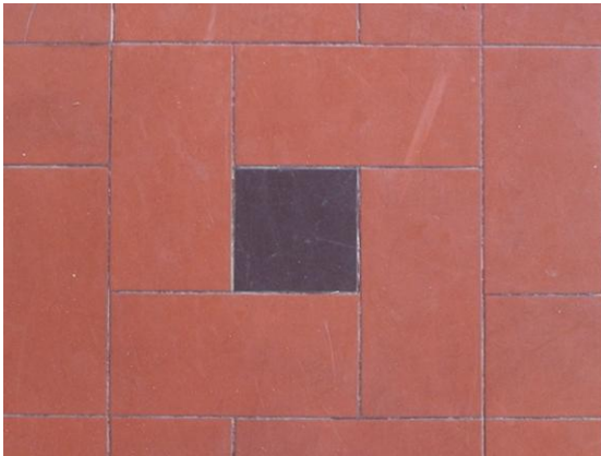
Detalhe do ladrilho hidráulico do pátio circundante ao salão principal, na ala oeste.
