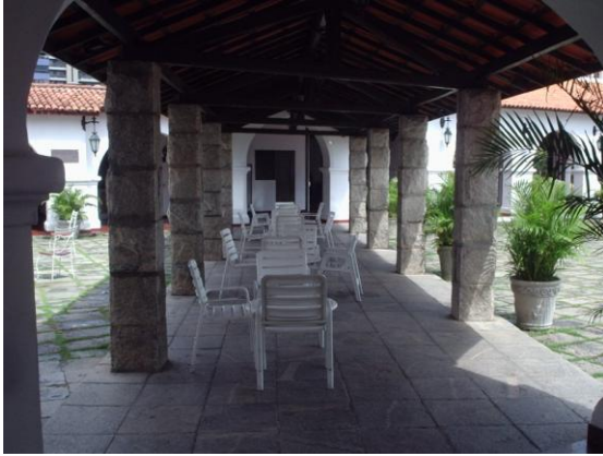
Vista do pórtico de acesso à ala oeste, a partir da varanda da ala sul.
