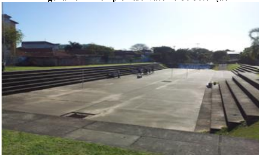
Figura 76 – Exemplo reservatório de detenção
