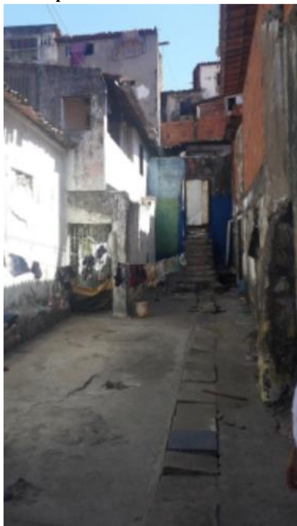
Figura 21 – Esgotamento exposto em via interna aos lotes da Rua Adarias de Lima.
