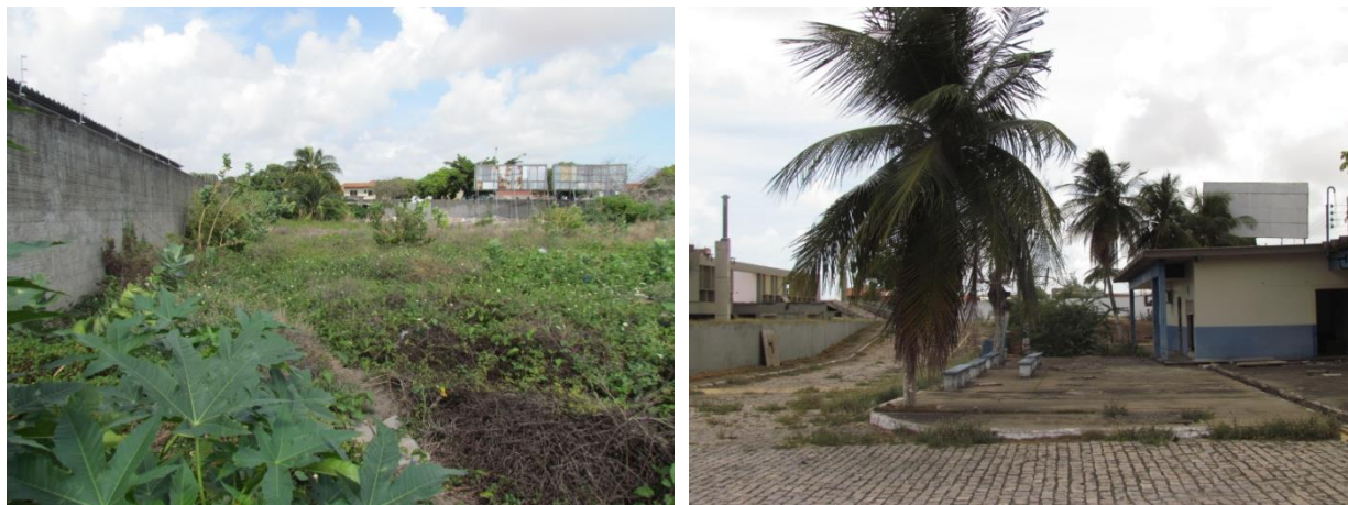
Figura 1.4 – Terreno proposto para implantação do empreendimento
