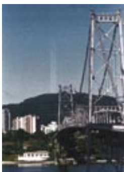
Ponte Hercílio Luz
