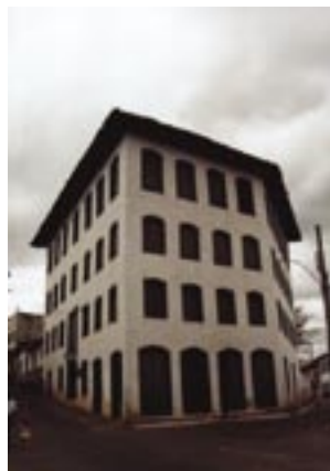
Casa na Avenida Getúlio Vargas
