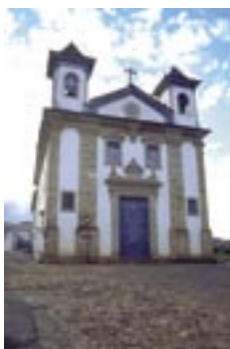
Igreja de Nossa Senhora do Rosário dos Pretos
