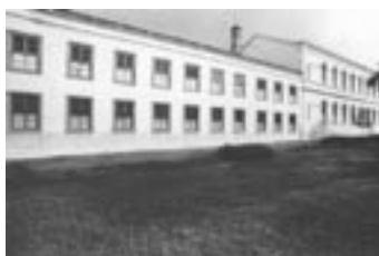
Edifício da Fábrica de Tecidos São Luís
