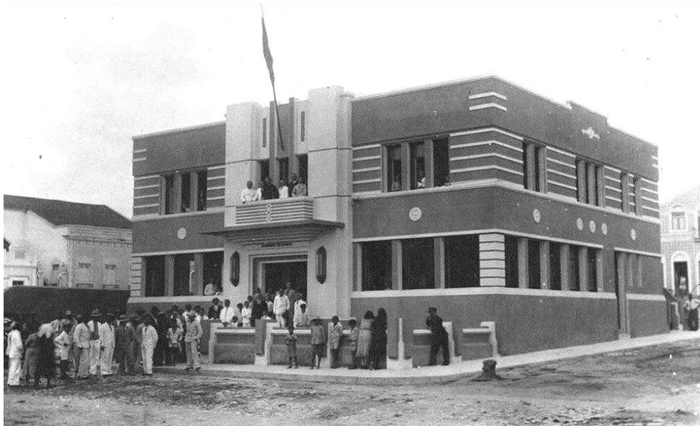
Fig. 26 - Agência dos Correios e Telégrafos, quando da inauguração, em 1932.
