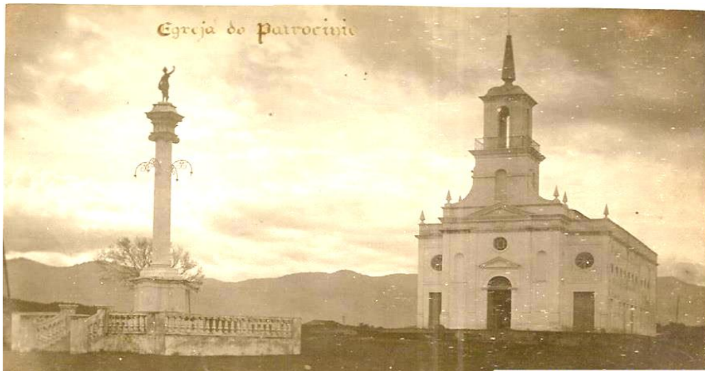
Fig. 16 - Igreja Nossa Senhora do Patrocínio, localizada próximo a Estação Ferroviária, com o monumento do I Centenário da Cidade, em 1941.
