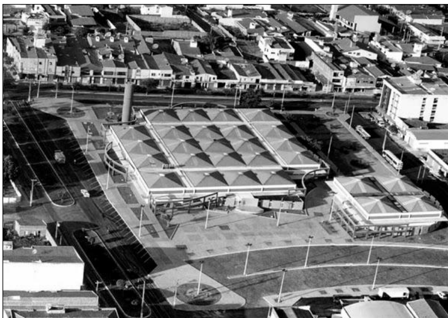
Fig. 45 - Mercado Novo do Junco, hoje adaptado para funcionar como Centro de Convenções.
