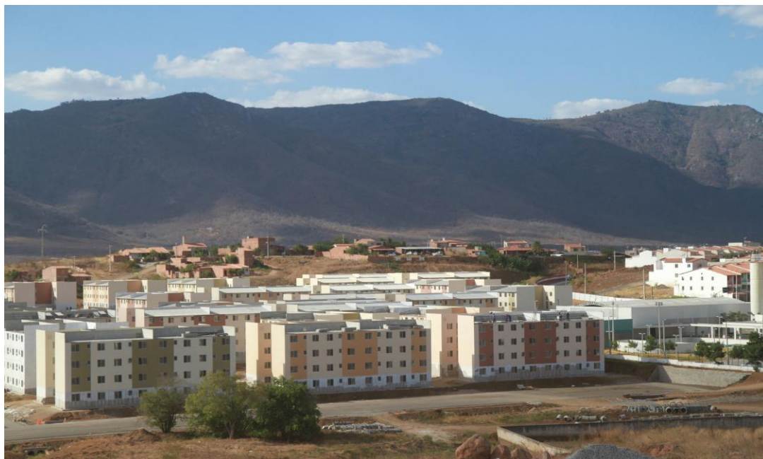
Fig. 58 - Conjunto Habitacional Orgulho Tropical em fase final de conclusão.
