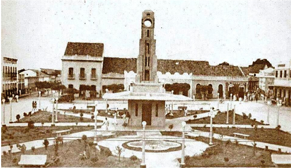
Fig. 29 - Praça da Coluna da Hora, antigo Mercado, com iluminação e fonte d'água.
