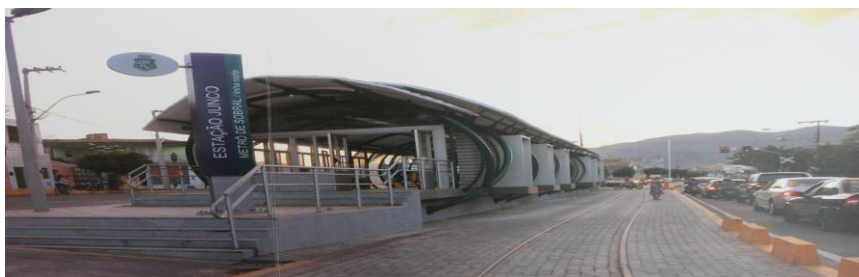
Fig. 60 - Estação do Junco em Março de 2014.
