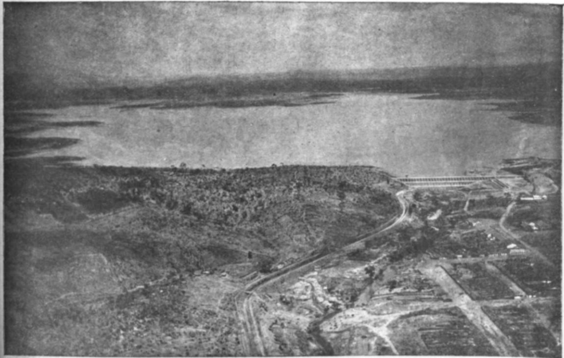
Panorama aereo da bacia hidraulica do açude "Lima Campos", vendo-se tambem a barragem de terra, banquetas e valletas de aguas pluvias, parte da torre e do canal principal e acampamento.
