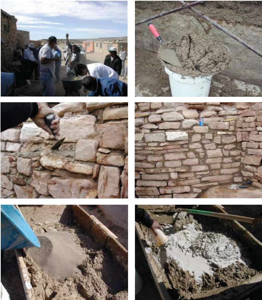
Fig. 3.14 – Reintegrações de muros de arenito. Argamassas de argila, areia, cal e fibras. Acoma City, EUA.
