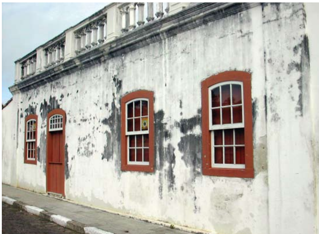
Fig. 4.14 – Excesso de aditivo pode resultar em problemas de biodeterioração. Casa Candemil, Laguna.
