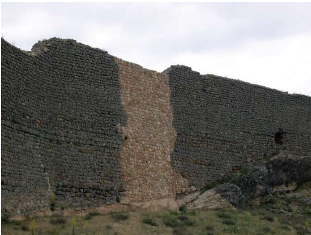
Fig.1.13 – Intervenções de consolidação nas Muralhas Atienza, Espanha.
