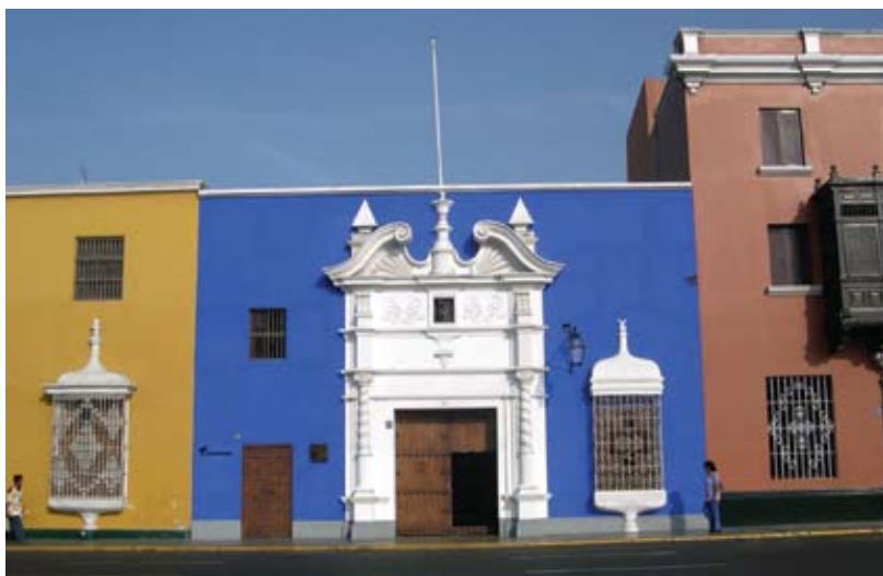
Fig. 4.9 – Cores vibrantes nas recuperações dos centros históricos de Campeche, México e Trujillo, Peru.
