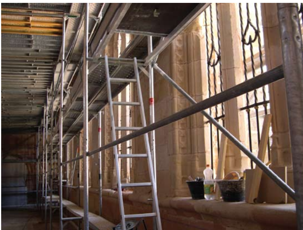
Fig. 1.14 – Intervenções de reparação em rendilhado de pedra, com argamassa e pó de pedra. Catedral de Sigüenza, Espanha.
