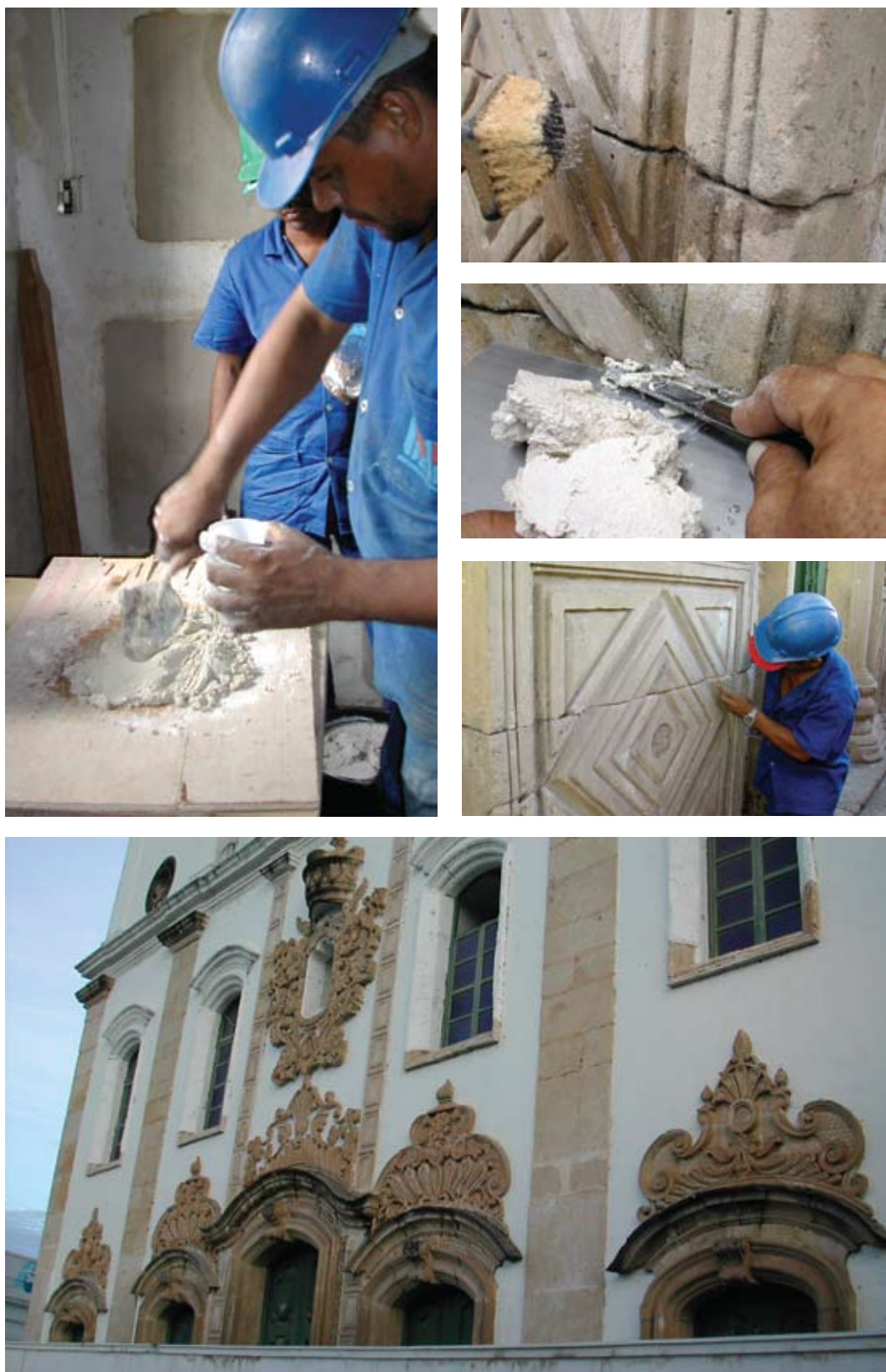
Fig. 3.15 – Teste de argamassa de rejunte. Ig. N.S. Corrente, Penedo.
