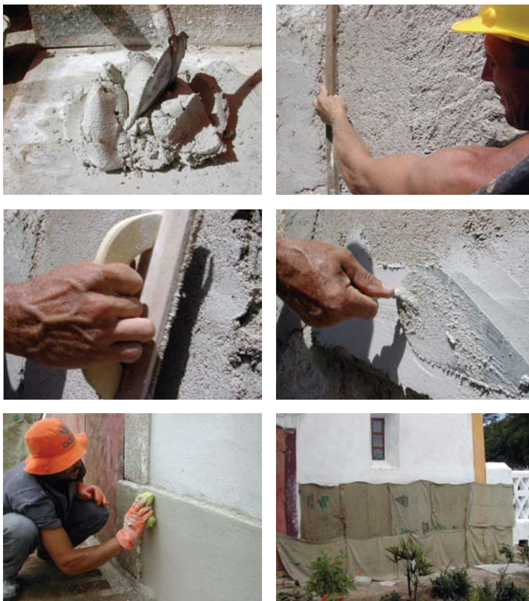
Fig. 3.25 – Aplicação de rebocos: emboço e acabamento. Ig. S. Sebastião e N.S. Necessidades, Ilha, SC.
