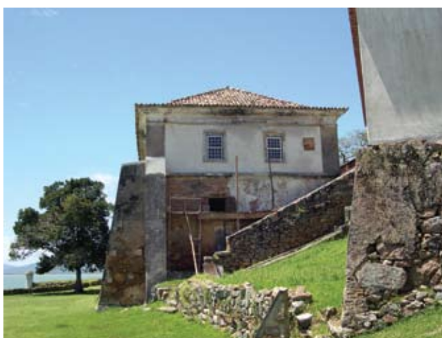
Fig. 3.24 – Aplicação de reboco, parede teste, Quartel da Tropa, Fortaleza de S.Cruz, SC.
