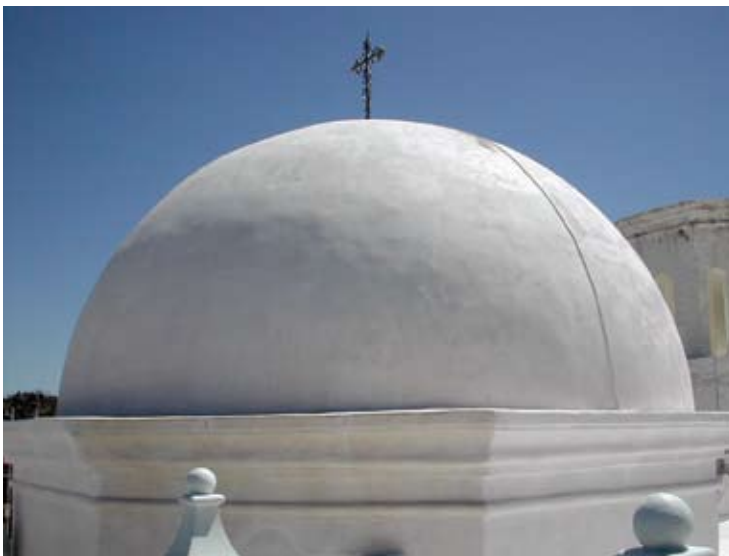
Fig.1.17 – Intervenções de restauração com rebocos de cal e mucilagem de cactos. Ig. San Xavier del Bac, Tucson, EUA.
