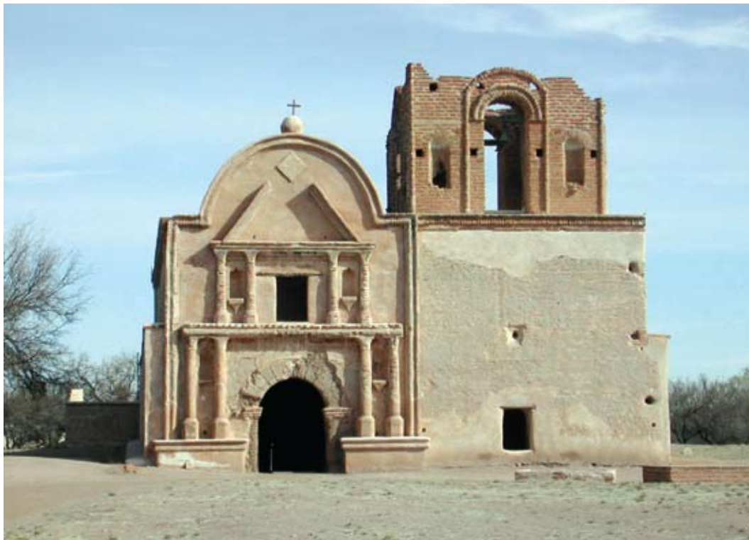
Fig. 1.15 – Intervenções de conservação e reparação de lacunas e fissuras, Tumacacori, Tucson, EUA.
