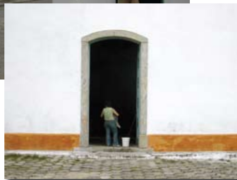
Fig. 4.8 – Recuperação da pintura das alvenarias e dos ornatos com a caiçação. Ig. N.S. Necessidades, SC.
