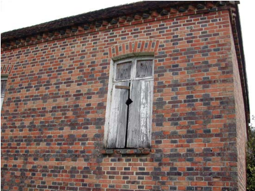
Fig. 1.11 – Sistema de argamassas e juntas em alvenarias de tijolos aparentes. Timbó, SC.
