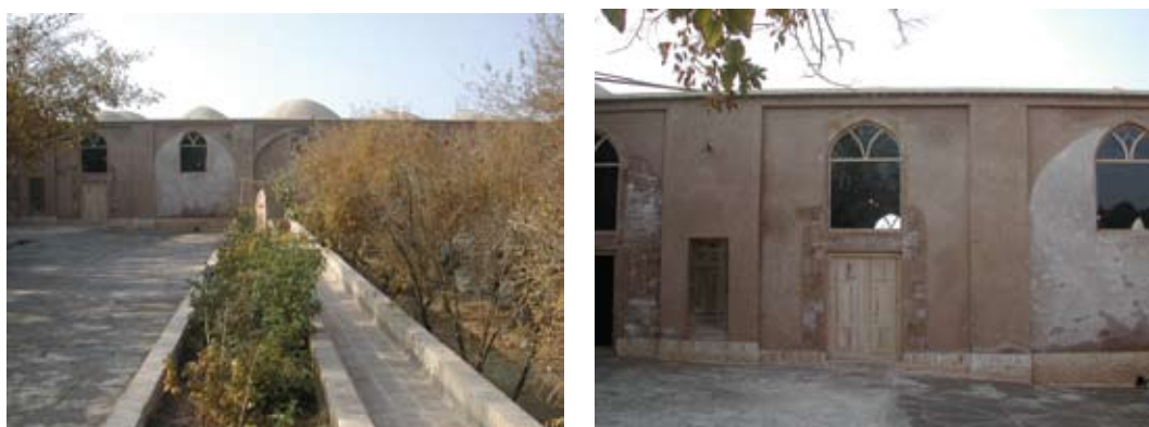
Fig.1.24 – Sais higroscópicos na recuperação de rebocos. Yazd, Irã.
