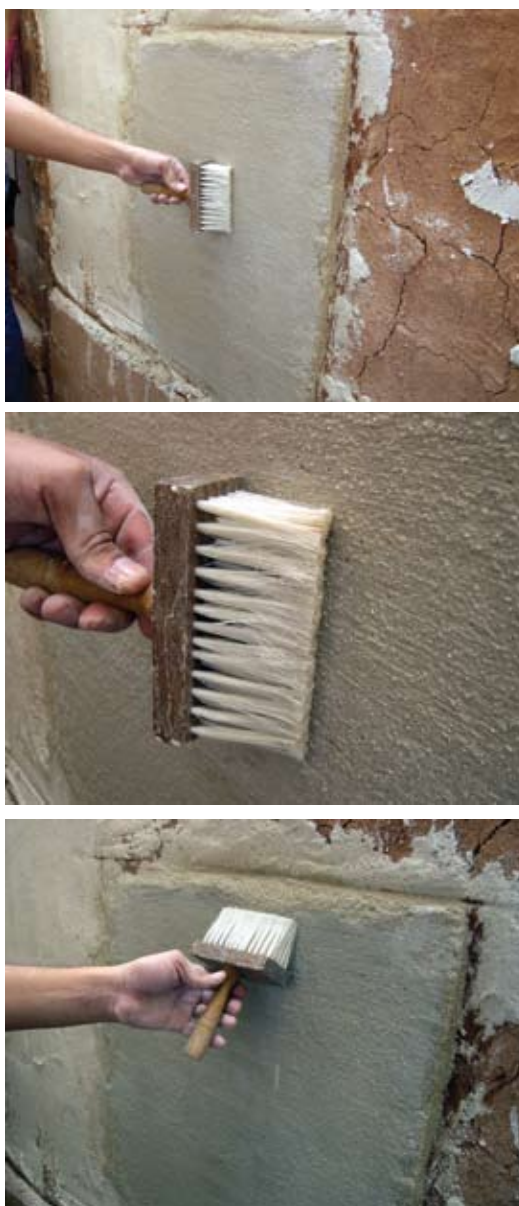
Fig. 4.16 – Técnicas de aplicação da caição. Oficina de argamassas de cal, Escola de Arquitetura, UFMG.
