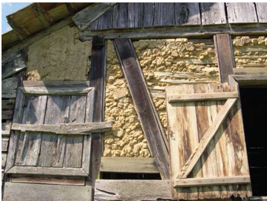
Fig. 3.7 – Fibras vegetais nas argamassas das taipas e rebocos das casas dos imigrantes em SC.
