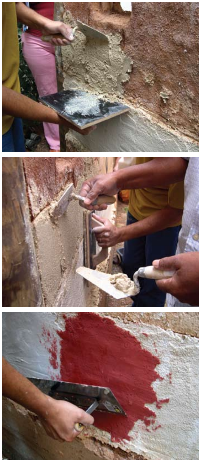
Fig. 4.20 – Treinamento prático com argamassas pigmentadas com mestres mineiros durante oficina de argamassas de cal da escola de arquitetura da UFMG.
