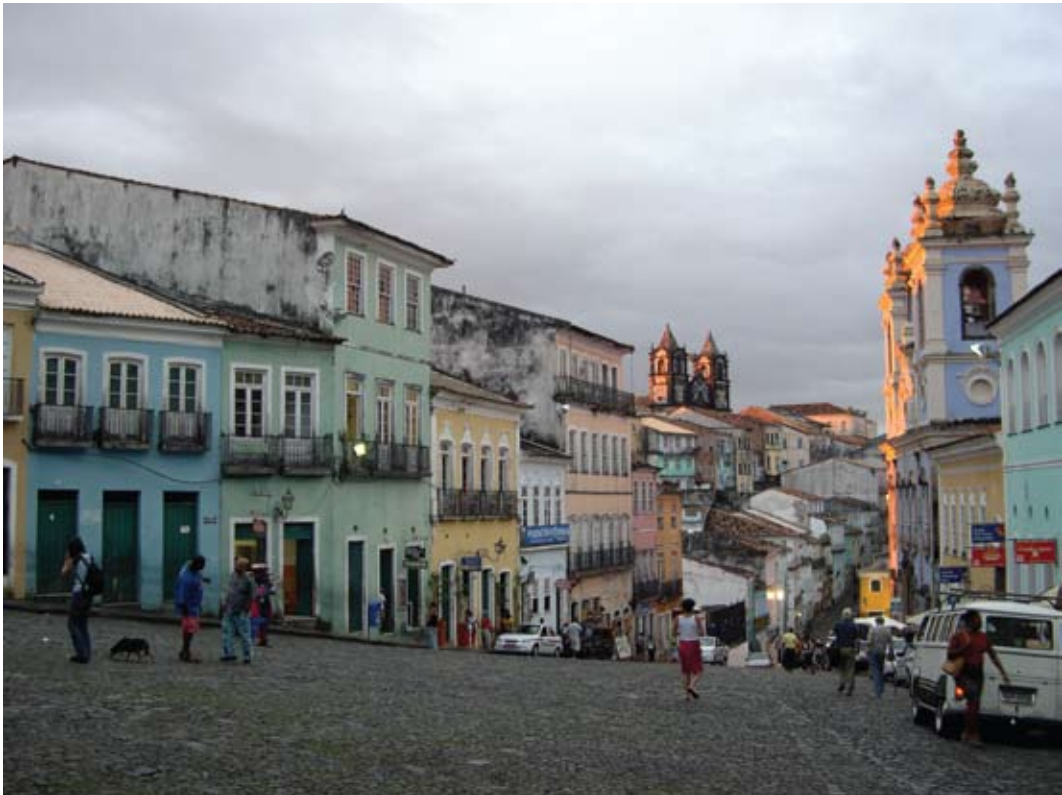
Fig. 4.10 – Problemas nos critérios de seleção dos materiais nas recuperações do centro histórico de Salvador.
