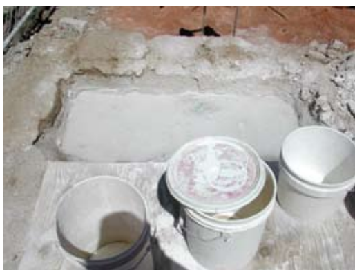
Fig. 3.11 – Preparo e aplicação de argamassas. San Xavier del Bac, EUA.
