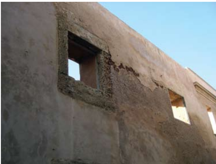
Fig.1.21 – Problemas de umidade acelerados por uso excessivo do cimento e contaminações de sais e compostos orgânicos, Essaouira, El Jadida, Marrocos.
