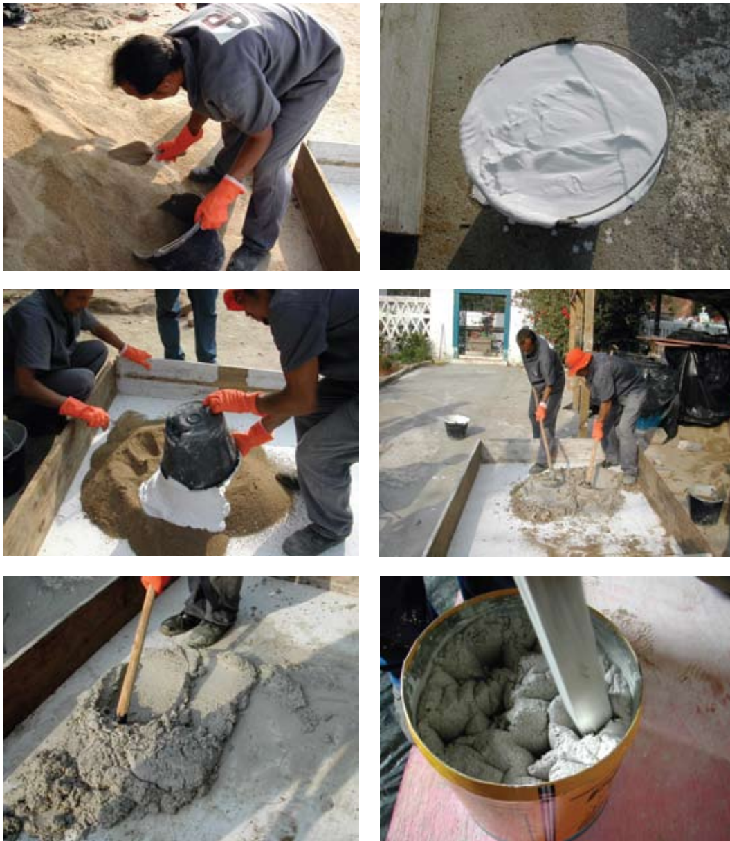
Fig. 3.10 – Preparação de argamassas manualmente. Ig. N.S. Necessidades, Florianópolis, SC e Ig. N.S. Corrente, Penedo, AL.
