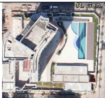
Implantação Fonte: Google Earth (acesso em 05.11.2014)
