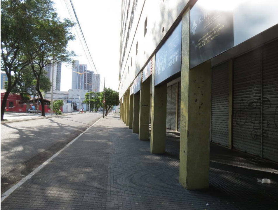
Figura 7 – Foto da galeria do Edifício Palácio Coronado
