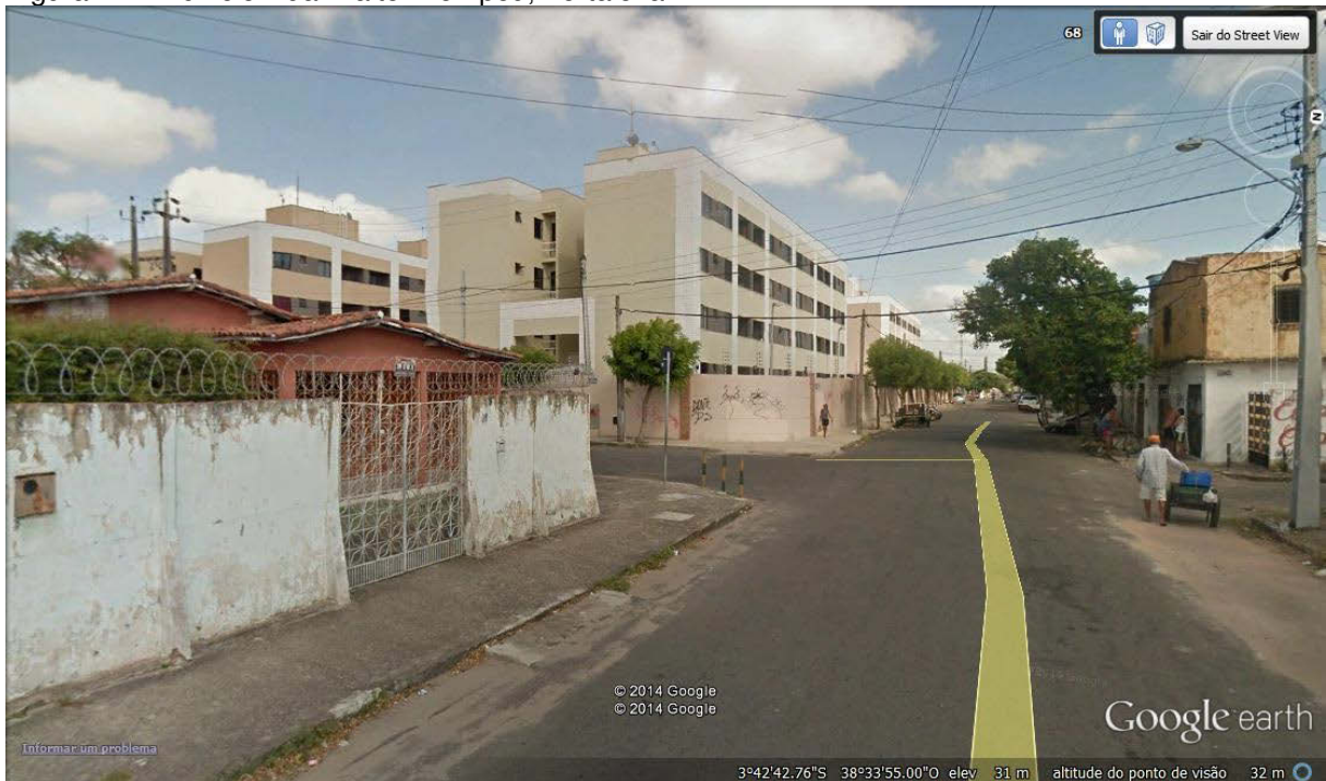
Figura 42 – Edifício Rua Walter Pompeu, Fortaleza
