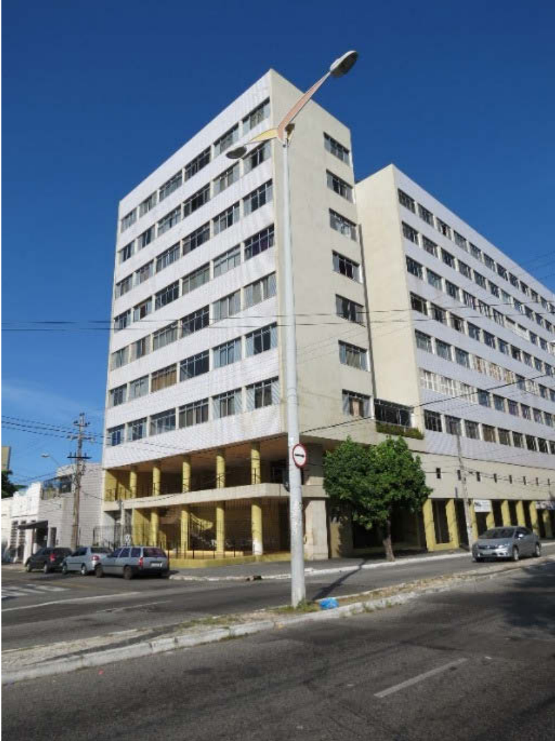
Figura 9 – Foto do Edifício Palácio Coronado
