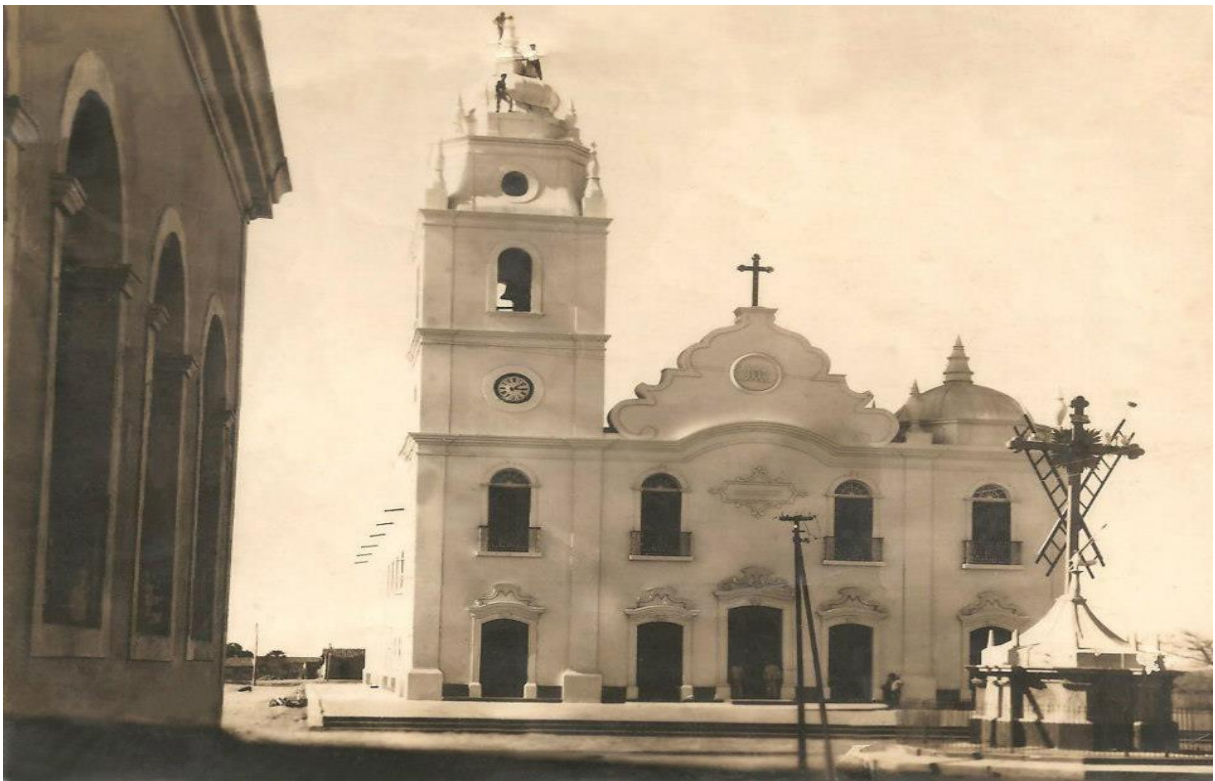
Figura 15 – Fachada da Igreja Matriz de Aracati (Igreja de Nossa Senhora do Rosário), início do século XX
