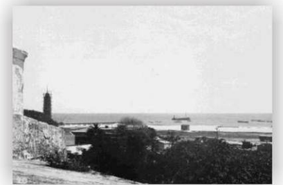
Fig. 89: Vista do Poço das Dragas a partir do Forte de Nossa Senhora da Assunção no final da década de 1920. Fonte: Arquivo Nirez.
