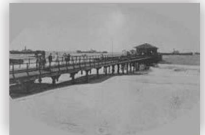
Fig. 84: Ponte Metálica no período de sua construção. Fonte: Arquivo Nirez.
