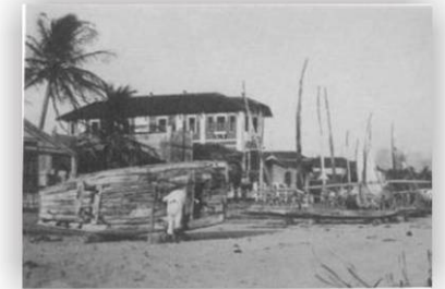
Fig. 121: Jangadas com bangalôs ao fundo, na praia de Iracema (década de 1940). A integração entre o tradicional e o moderno foi a marca principal do projeto de Saboya Ribeiro Fonte: Chaves et al, 2006, p. 60.
