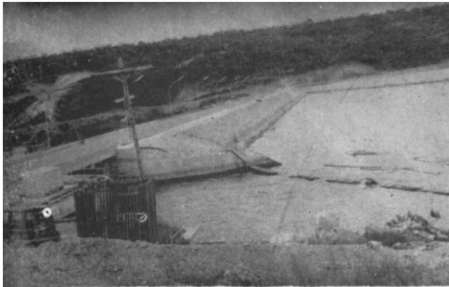
FIG. 1 — LAGO "ISRAEL PINHEIRO". VISTA DA BARRAGEM
