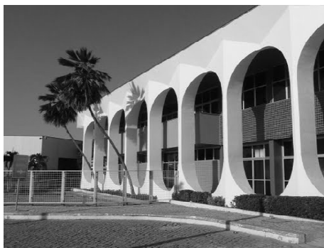
Figura 7: Centro de Convenções do Ceará (1973) – (Fonte: http://www.panoramio.com/photo/47040385 )
