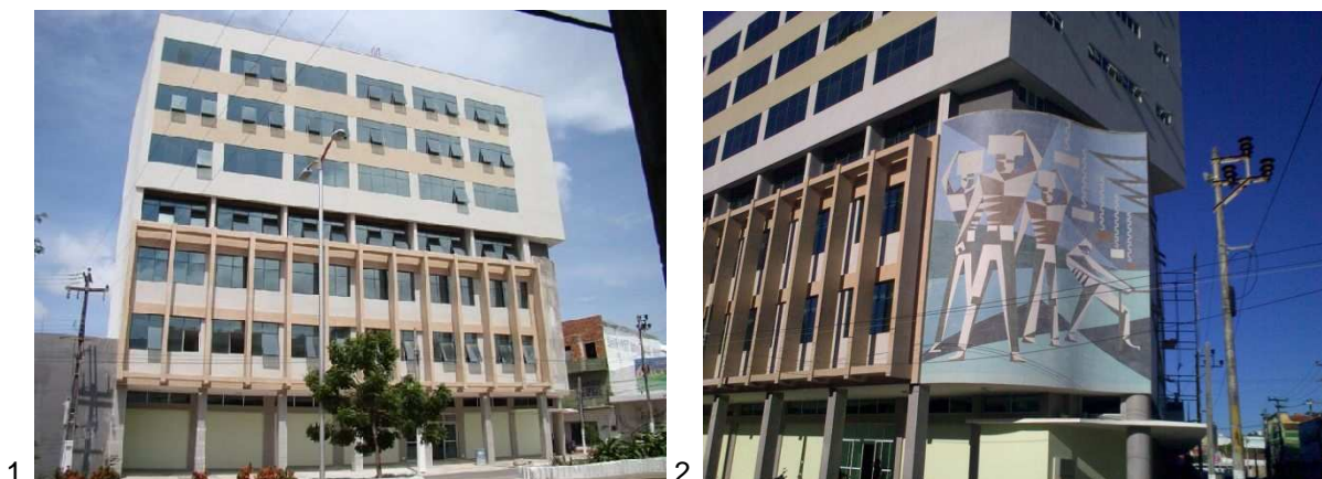
Figura 9: Centro de Exportadores do Ceará (1962) – 1: Foto do edifício reabilitado; 2: Detalhe do Mural “Estivadores” de Zenon Barreto (Fonte: Acervo Arq. Rafael Cunha)
