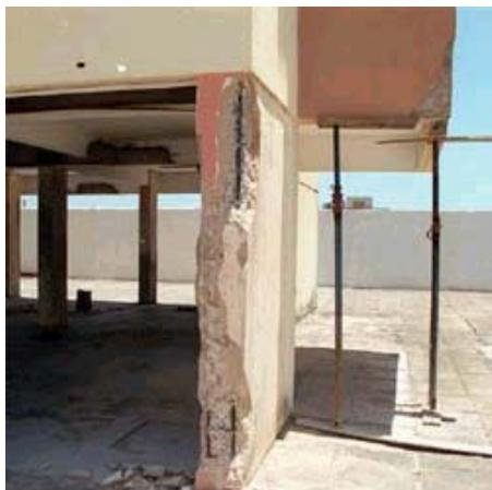
Foto 29 – Edifício da Praia do Futuro passando por reforma por ter sua estrutura comprometida pela maresia.
