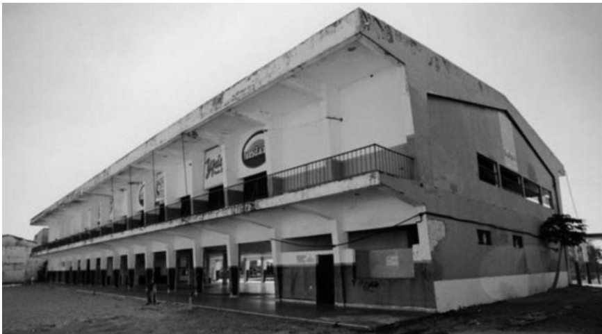
Fig. 69 – Vista externa do bloco principal evidencia a estrutura
