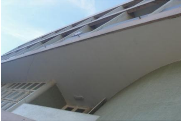
Fig. 31 – Transição entre os pavimentos
