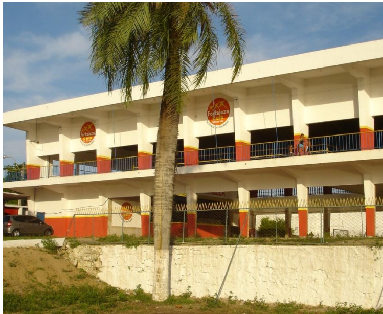
Fig. 73 – Fachada do bloco principal antes da sua reforma
