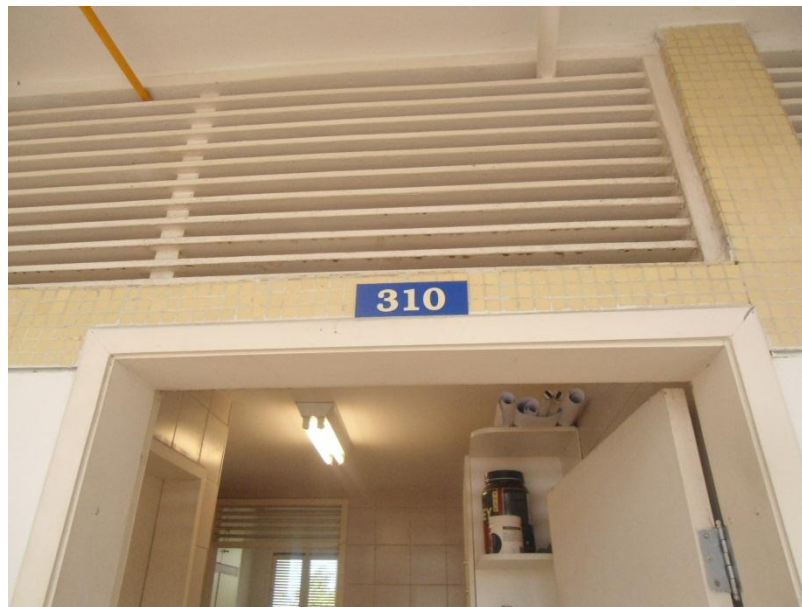
Fig. 44 - Detalhe bandeira e ventilação cruzada
