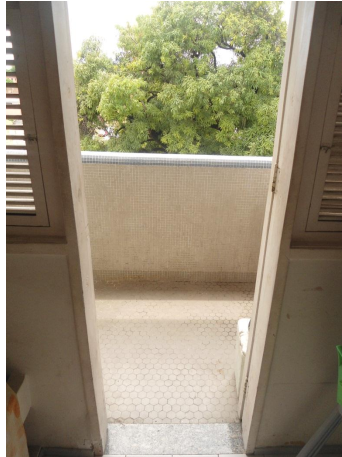
Fig. 36 – Detalhe da varanda e revestimentos
