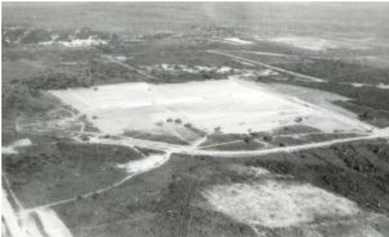
Fig. 81 – Área destinada à construção do estádio
