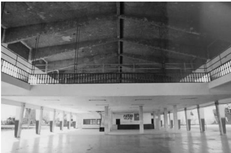
Fig. 63 – Vista interna do bloco principal mostra a modulação da estrutura e a laje inclinada em concreto
