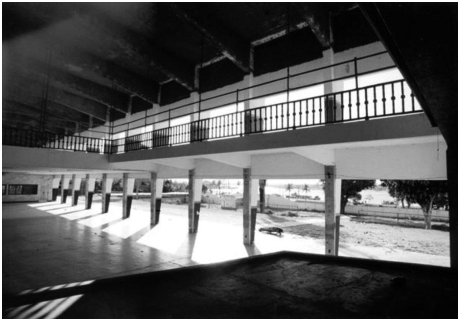
Fig. 71 – Vista do salão do bloco da sede social a partir do palco, com vista direta para o Rio Ceará
