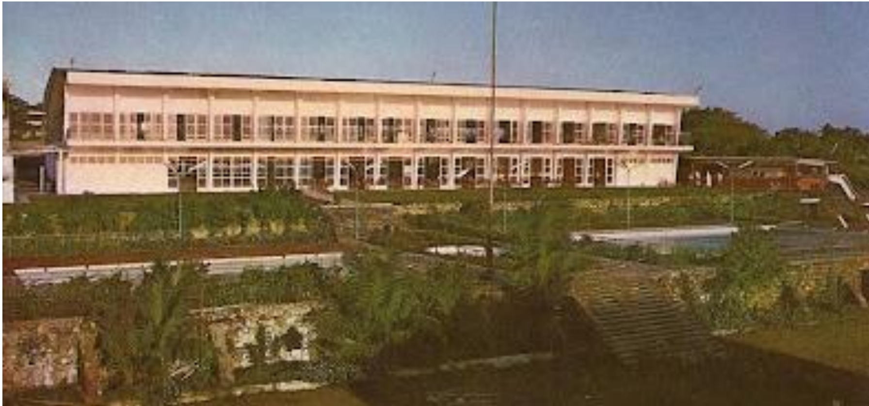
Fig. 54 – Fachada do Clube de Regatas da Barra do Ceará
