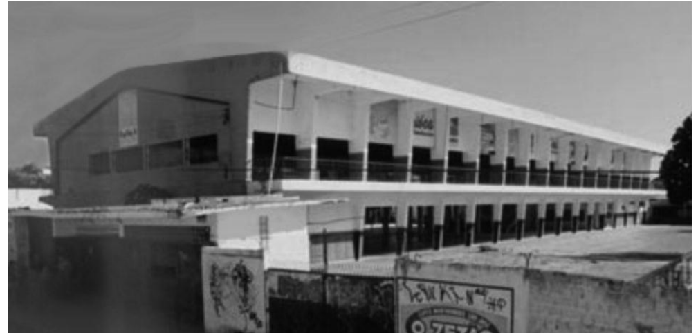
Fig. 68 – Vista externa do bloco principal pelo acesso
