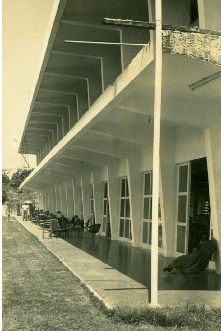
Fig. 61 – Sequência dos pórticos na fachada
