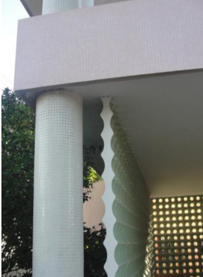
Fig. 29 – Painel de cobogós e estrutura independentes
