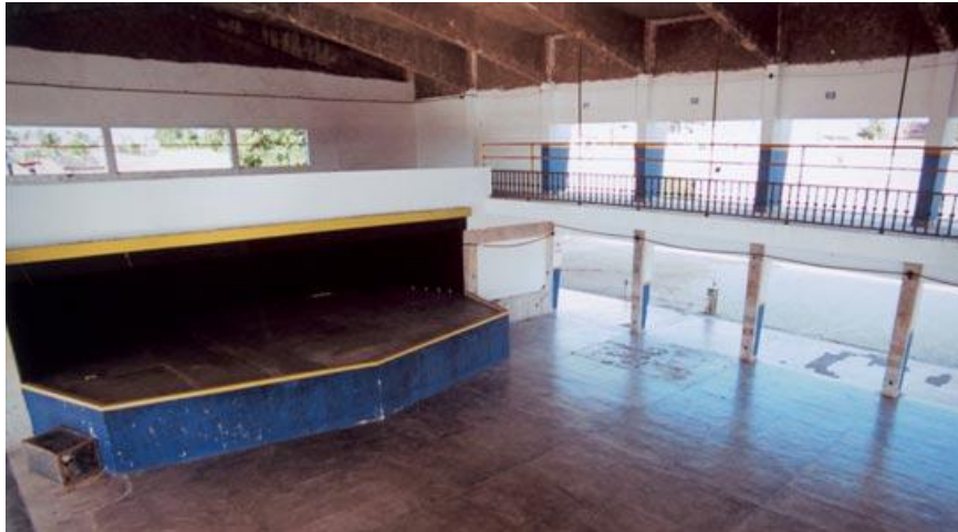
Fig. 67 – Vista do palco através do vazio do salão do pavimento superior
