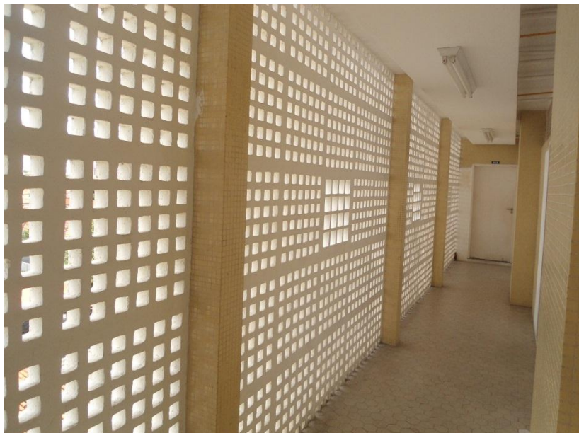
Fig. 43 - Circulação do pavimento-tipo e paginação cobogós
