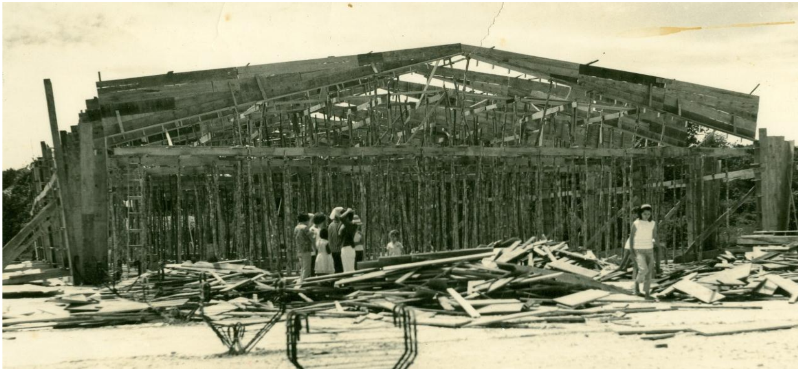
Fig. 60 – Visita às obras do bloco principal.
