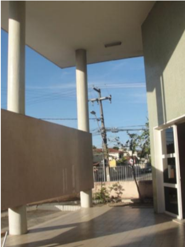
Fig. 27 - Pilares laterais e pé-direito duplo
