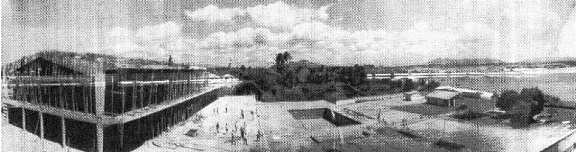
Fig. 72 – Fotografia panorâmica das obras do CRAB
