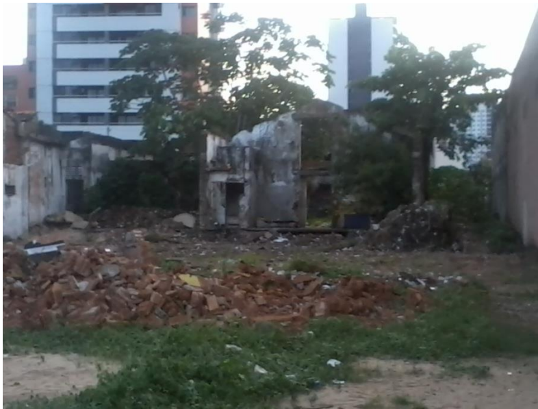
Figura 10: Terreno que serve de abrigo aos usuários de crack.
