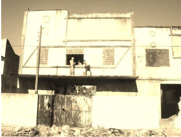
Figura 6: (Re) construção da casa.
