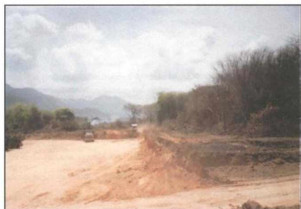
Escavação de trincheira para material de cobertura 2006
