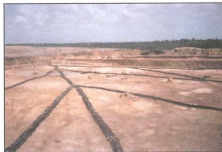
Trincheira com drenagem assentada - 2006
