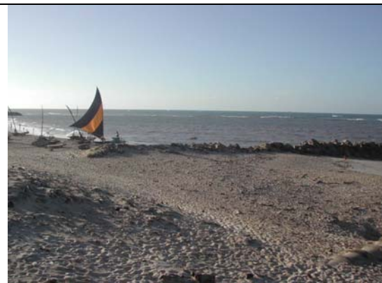
Fotografia 8 - Faixa de praia associada a obras de engenharia costeira (espigão) objetivando controlar a erosão costeira (Fonte: Projeto Orla, setembro de 2005).
