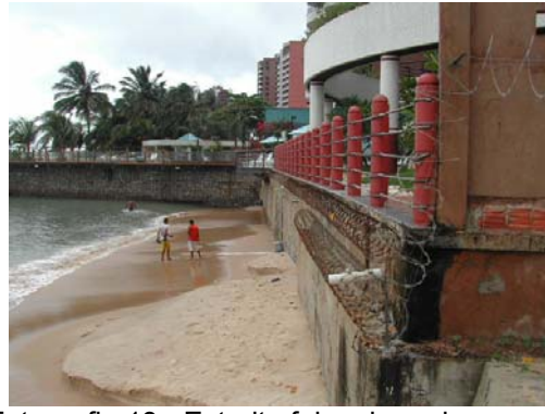
Fotografia 13 - Estreita faixa de praia com a presença de muro de concreto e edificação na faixa de praia. Trecho com déficit de areia e com acesso indireto à zona intermaré. Privatização da orla através da construção de edifícios multifamiliares e hotéis (Fonte, Jeovah Meireles, janeiro de 2005).
