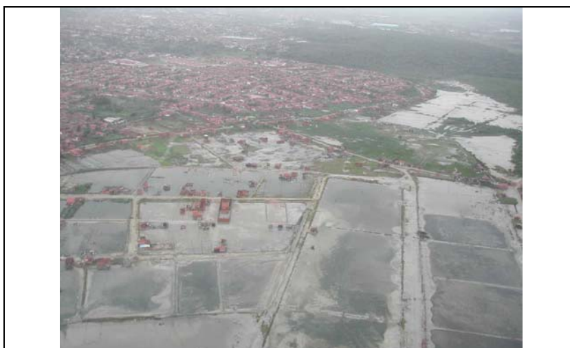
Fotografia 2 - Limite sudoeste evidenciando salinas abandonadas sendo utilizadas para a construção de moradia. Resultado da pressão urbana em outras áreas da cidade, expulsando os moradores para áreas irregulares. Áreas de risco de inundações e com impactos sócio-ambientais de elevada magnitude (Fonte: Jeovah Meireles, março de 2005).
