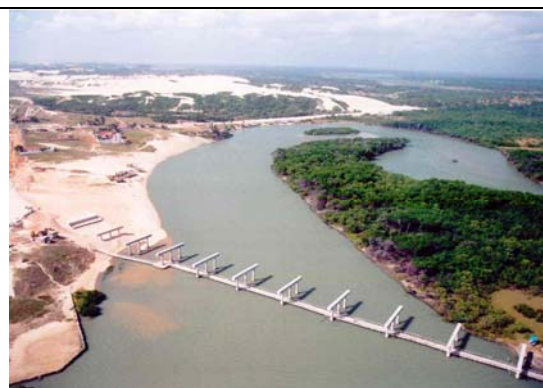
Fotografia 25 - Vista panorâmica do rio Cocó com a ponte em processo de construção. Verificar a presença de barracas de praia. Vegetação de mangue e ao fundo, as dunas do Parque Natural (Fonte: Jeovah Meireles, setembro de 2004).
