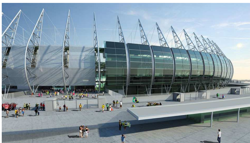
Figura 08: Perspectiva Eletrônica Fachada acesso área VIP e imprensa (Fonte: www.vigliecca.com.br/pt-BR/projects/castelao-arena )
