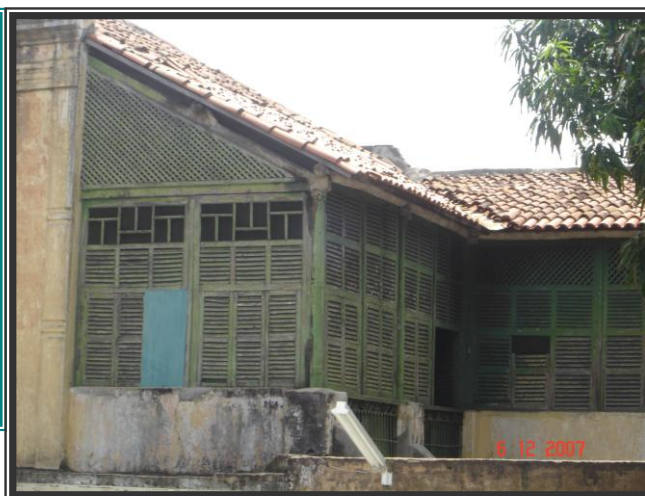
Imagem 19: Detalhe da esquadria da fachada dos fundos confeccionada em treliças de madeira. Fonte: Arquivo pessoal
