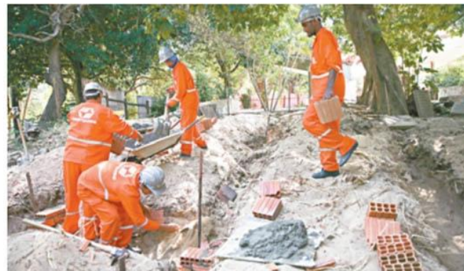
Entre as alterações, está a criação de um Centro de Educação Ambiental e até a implantação de passeio de barco. De acordo com a Seuma, há 15 dias, homens estão trabalhando na requalificação do espaço FOTO: NATINHO RODRIGUES
