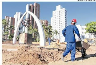
Na área central, intervenções estão 20% concluídas
