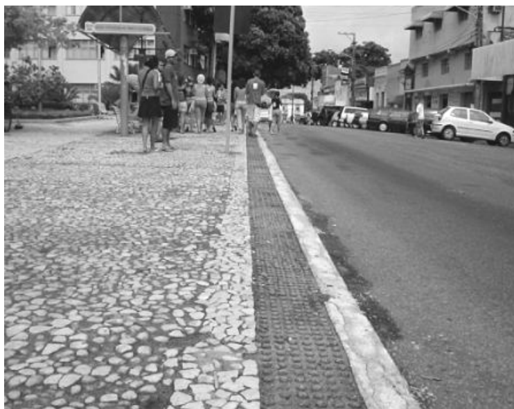
Figura 5.6: Superfície tátil ao longo do meio fio em calçada do Centro de Natal–RN (2004).
