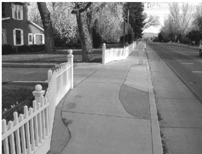
Figura 5.5: Rampa de acesso para automóveis (Fonte. PBIC, 2005).
