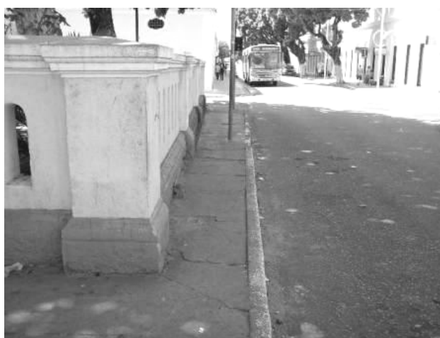
Figura 3.5: Calçada com dimensionamento insuficiente para a circulação de pedestres no Centro de Fortaleza-CE (2005).
