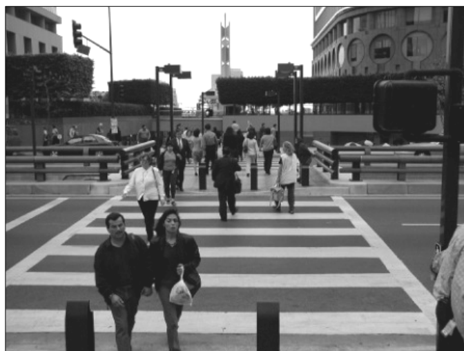
Figura 5.13: Travessia de pedestres canalizada por barreiras em Los Angeles, Estados Unidos (Fonte: PBIC, 2005).
