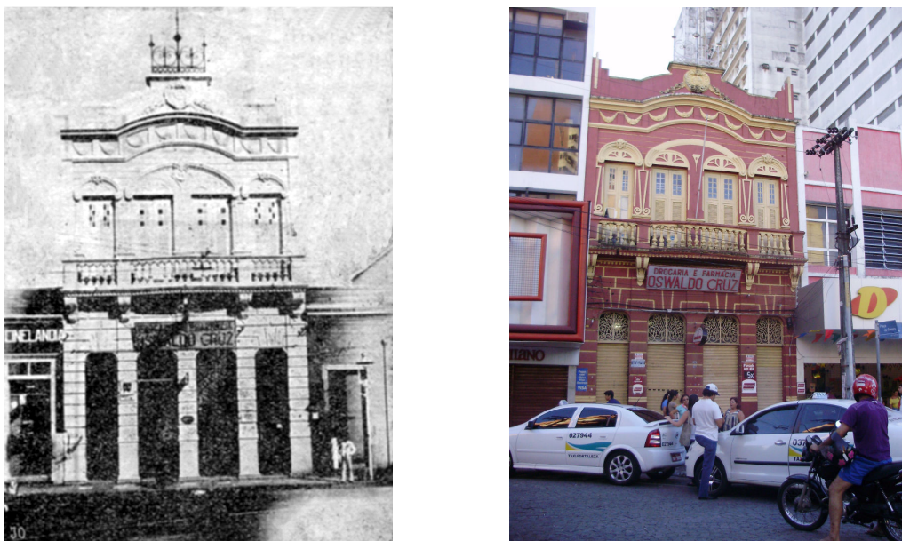
Figura 8: Imagem da Farmácia no início de suas operações e Imagem atual da farmácia Oswaldo Cruz, comprovando a manutenção de sua fachada. Foto: Arquivo Nirez, sem data; Anna Pontes, 2011.
