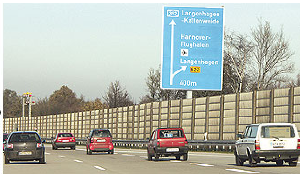
Figura 3.4: Barreira acústica instalada em rodovia que liga a cidade de Hanover, na Alemanha, a seu aeroporto
