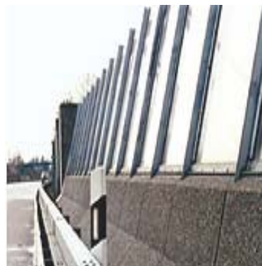
Figura 3.11: Barreira mista executada em concreto e acrílico
