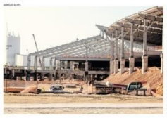
AVIAÇÃO Modernização do Aeroporto de Fortaleza
