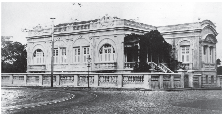
Figura 12 - Casa Luiz de Moraes Correia. Demolida. (Col. Nirez).
