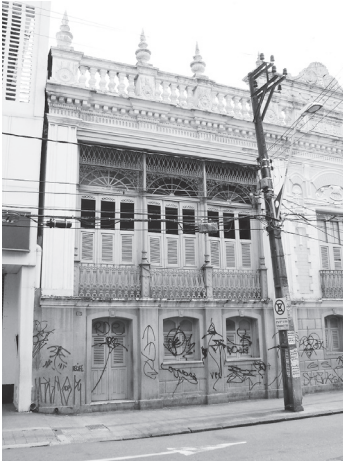
Figura 17 - Casa Carvalho Motta. Foto atual do “terraço envidraçado”. (Col. Autor).
