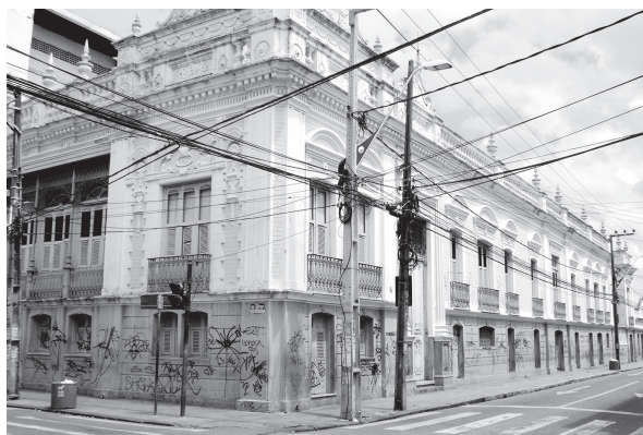
Figura 22 - Antiga sede do DNOCS (Casa Carvalho Motta). Foto atual. Observar pichamento das fachadas e o empacotamento visual provocado pela rede elétrica. (Col. Autor).
