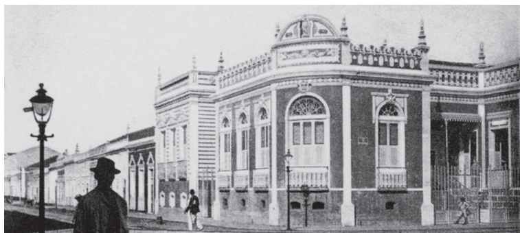
Figura 4 - Casa Dr. João Moreira, na esquina (demolida), e casa na rua Barão do Rio Branco, 520. Observar nesta última, à aplicação de “guarnecidos” em listras nas fachadas. ( Album do Ceará , 1908).
