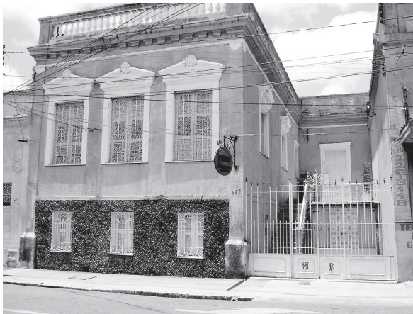
Figura 5 - Casa rua B. Rio Branco, 520. Foto atual. Edificação alterada: com a remoção dos “guarnecidos” nas fachadas e aplicação de encasque de pedra na altura correspondente ao portão. (Col. Autor).
