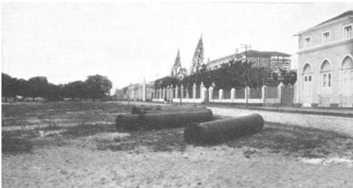
Fotografia 12 – Tubos do Encanamento de água
