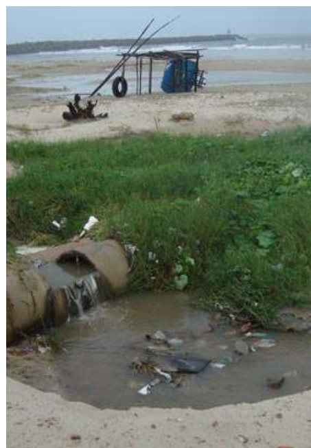
Figura 8 - Emissário de drenagem. Fonte: Rebouças, 2009.
