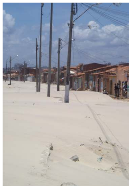
Figura 5 - Vista da Rua Pontamar (julho de 2009). Fonte: Rebouças, 2009.
