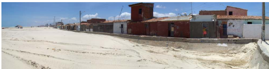
Figura 26 - Foto panorâmica da mureta da Rua Ponta Mar, com retirada mecânica de sedimentos em outubro de 2008. Fonte: Rebouças, 2008.
