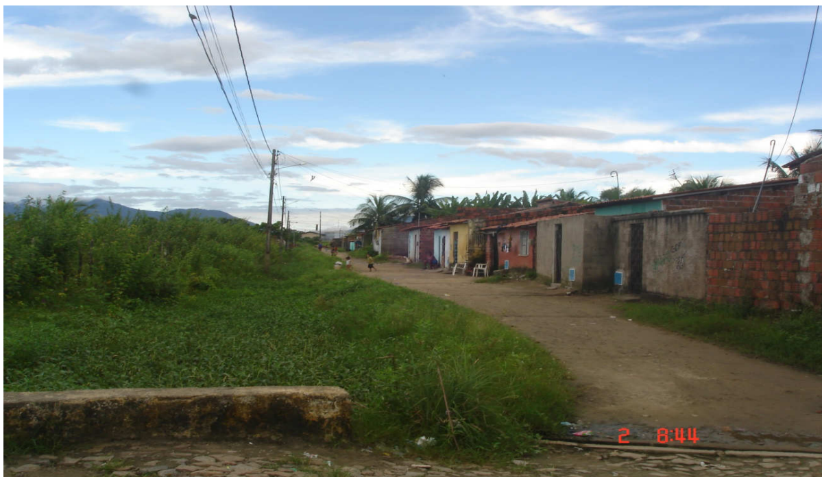
Rua Santa Adelaide, ao lado de um córrego que recebe dejetos das fábricas locais. (Favela)
